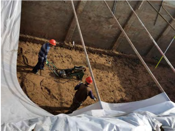
罐区底部铺膜
