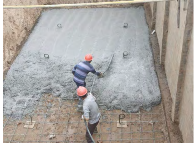
罐区底部钢筋网及混凝土浇筑
