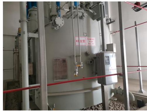
图 4-8 #2 主变压器
