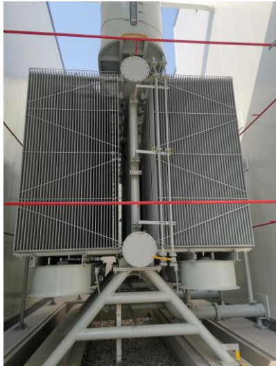
图 4-11 主变散热器
