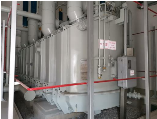
图 4-7 #1 主变压器
