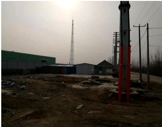
图 2-1 三合山变电站站北 10m 看护房
