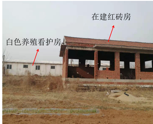
图 2-2 110kV 林山甲线 44#/110kV 林山乙线 44#~110kV 林山甲线 45#/110kV 林山乙线 45#线北 11m 白色养殖看护房及线北 21m 在建红砖房
