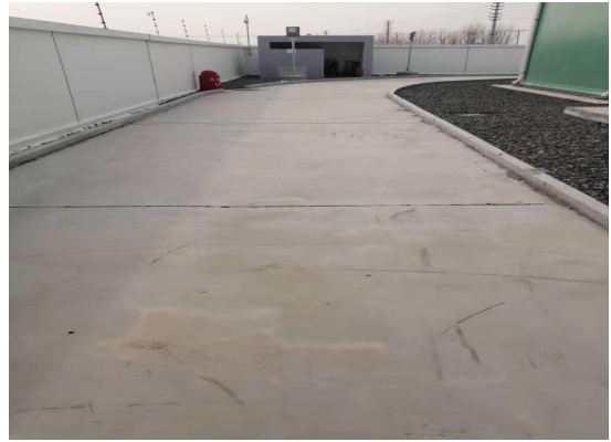
图6-2 变电站内路面硬化
