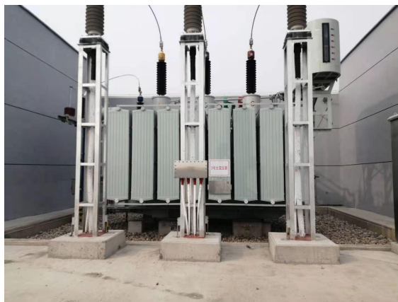
图4-8 2#主变压器
