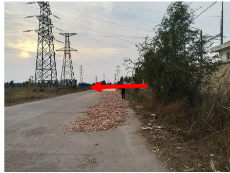
图 4-4 刘家庄 110kV 变电站南侧
