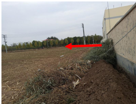
图 4-6 刘家庄 110kV 变电站北侧
