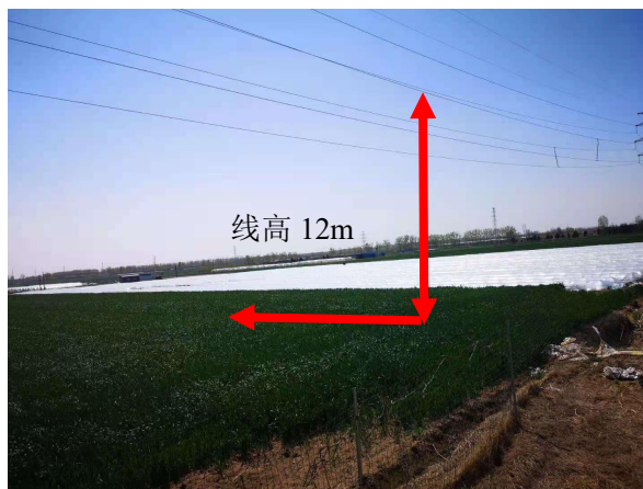
图 7-1 110kV 挪普乙线 96#-97#和 110kV 平莱线 111#-112#向南衰减
