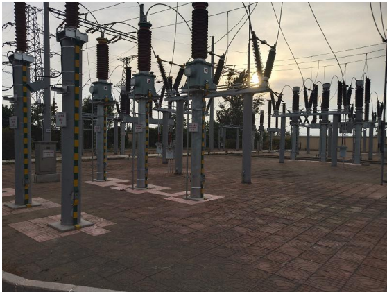
图 4-9 110kV 户外 AIS
