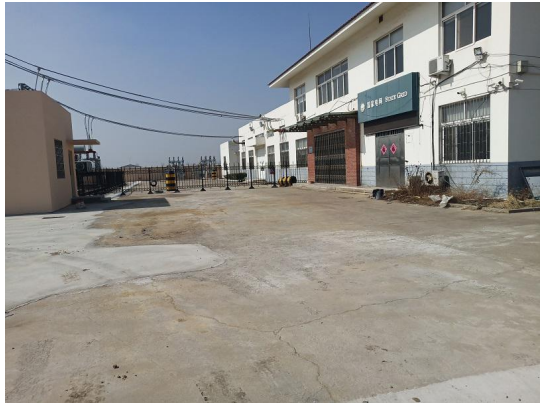
图6-3 变电站内路面硬化
