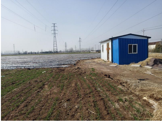
图 2-1 110kV 挪普乙线 96#-97#和 110kV 平莱线 111#-112#线北 18m, 板房
