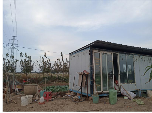
图 2-2 110kV 挪普乙线 93#-94#和 110kV 平莱线 108#-109#线东 5m, 东尖庄村板房
