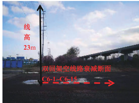
图 7-4 110kV 吞水线衰减断面
