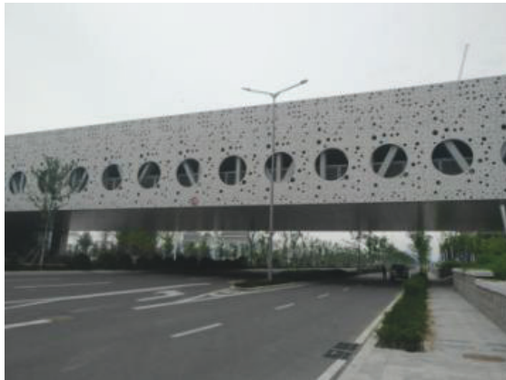
图2-7 110kV沭水线单回电缆上方中科院连廊
