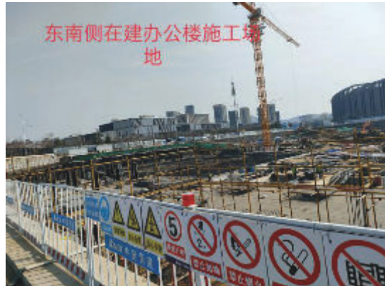
图2-2 蓝谷110kV变电站东南侧5m在建办公楼
