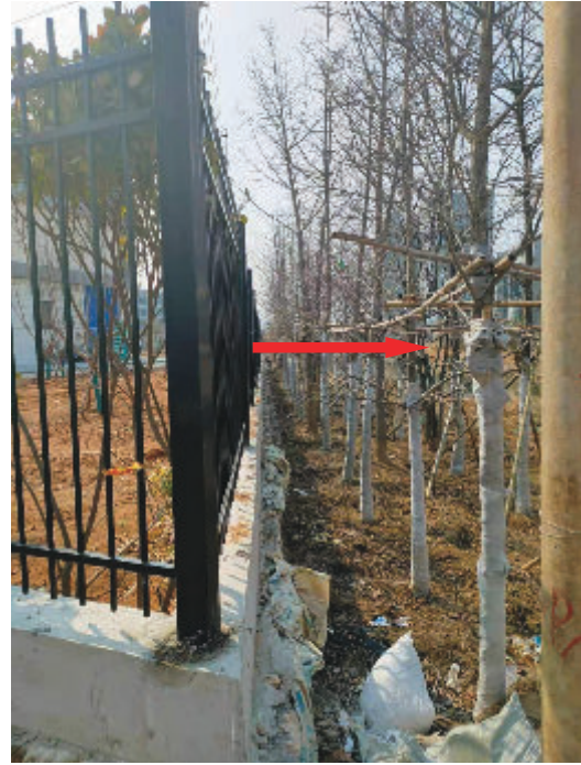
图 4-4 蓝谷 110kV 变电站西侧
