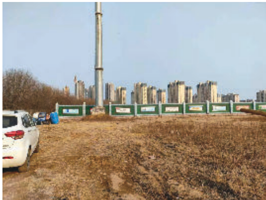
图2-5 110kV山水线 \zeta_1-4\# ~ \zeta_1-8\# 线东3.8m在建青岛金蝶软件园(云栖蓝谷1.1期)
