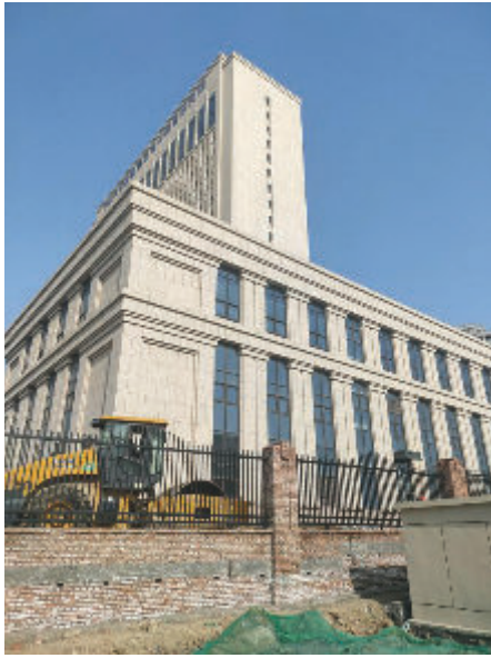
图2-1 110kV安子变电站西侧2.5m中国船舶集团海洋工程研究院
