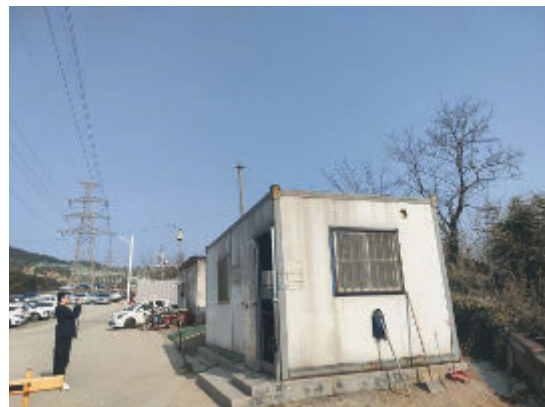
图2-4 110kV前港线/110kV前安线15#-16#线东5.5m停车场门卫
