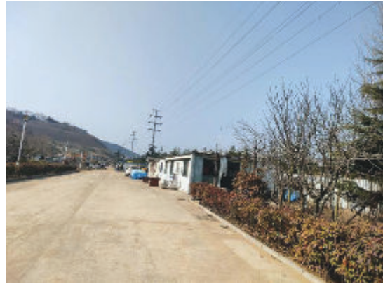
图2-2 110kV前港线/110kV前安线9#-10#线东9.8m临时施工板房
