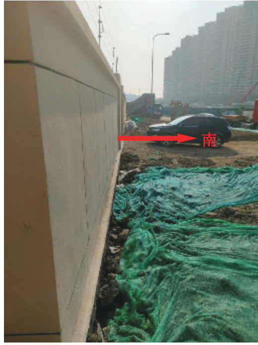
图 4-4 110kV 安子变电站南侧
