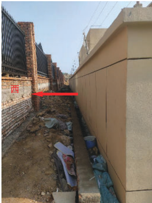
图 4-5 110kV 安子变电站西侧
