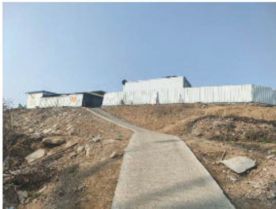
图2-3 110kV前港线/110kV前安线15#-16#线西21.7m铝合金收购站
