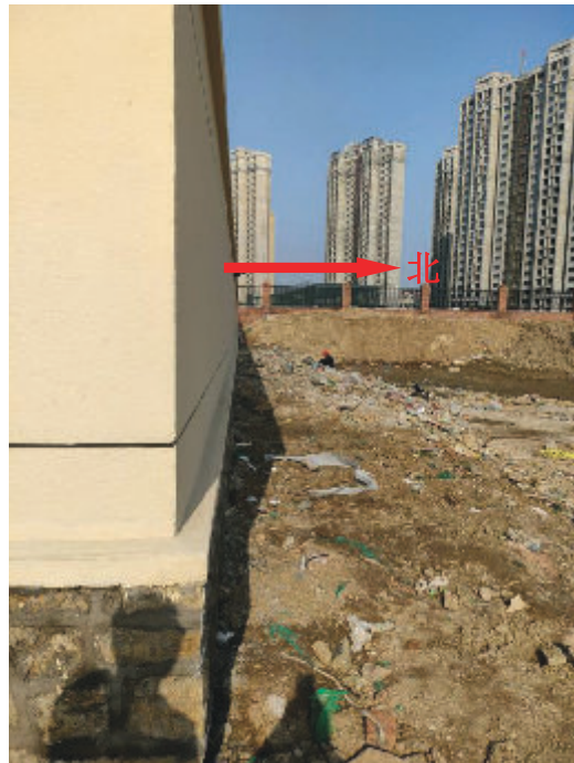
图 4-6 110kV 安子变电站北侧
