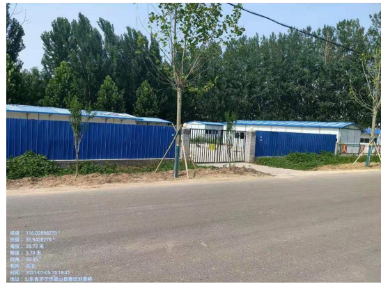
图2-2 110kV忠路线2#/110kV忠杨线2#~110kV忠路线3#/110kV忠杨线3#之间线北26m在建厂房
