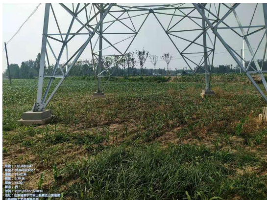
图6-1 架空线路塔基下方土地恢复
