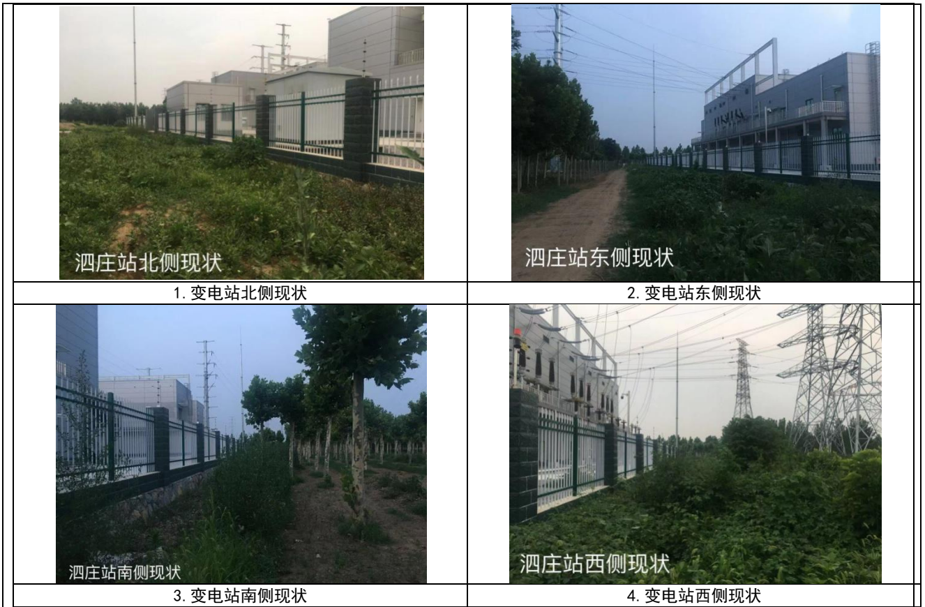
图 4-2 220kV 泗庄站周围现场照片
