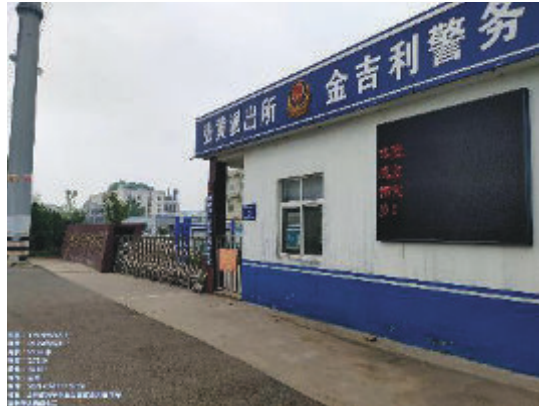
图2-8 110kV金台线4#~5#线西5m山东金吉利新材料有限公司
