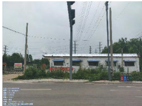
图2-2 110kV金台线2#~3#线下新开源油墨厂区
