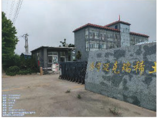
图2-4 110kV金台线3#~4#线西5m迈克瑞稀土有限公司
