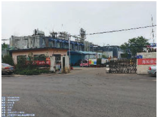
图2-6 110kV金台线3#~5#线东19m正鑫化工厂区
