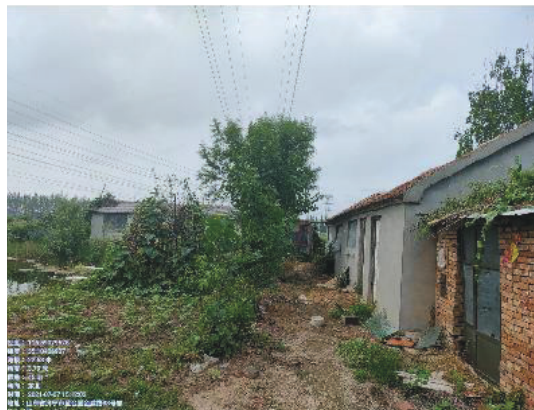
图2-14 110kV金邵线1#~2#之间线下养殖看护房
