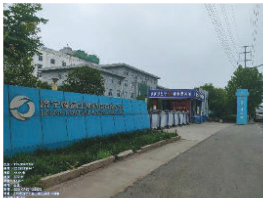
图2-12 110kV金台线5#~7#线西5m济宁峰润生物科技有限公司
