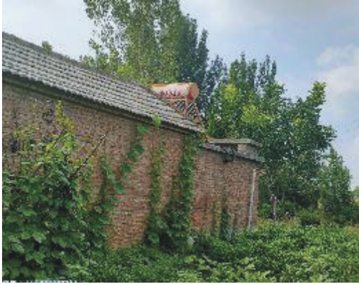
图2-19 110kV金邵线22+1#~22+2#之间线东南7m西刘村西北部民房
