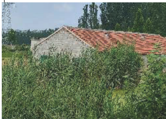
图2-17 110kV金邵线22#~22+1#之间线东北10m西刘村民房
