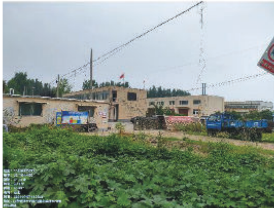
图2-3 110kV金台线3#西北19m鱼台介鑫化工有限公司
