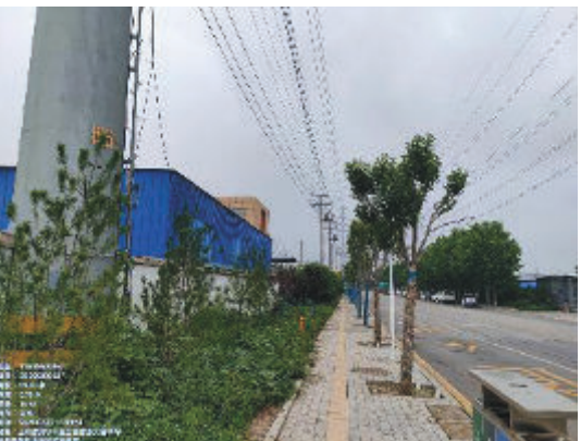
图2-5 110kV金台线3#~4#线东19m康盛彩虹生物科技
