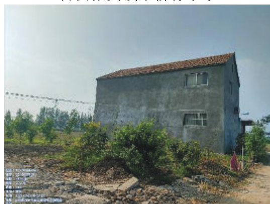
图2-15 110kV金邵线5#~6#之间线南11m民房
