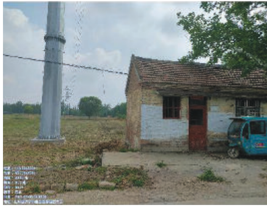
图2-20 110kV金邵线24#~25#之间线南11m民房
