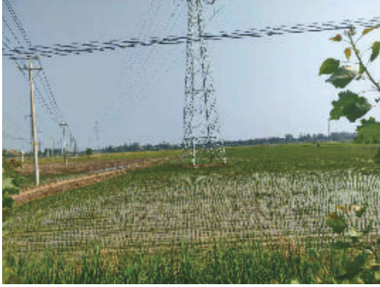
图 \zeta -1 塔基下方土地恢复情况
