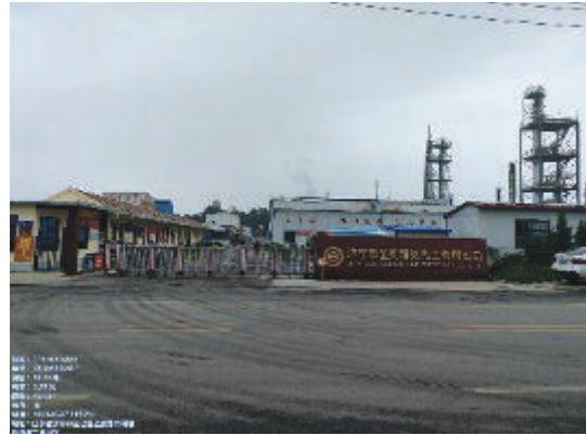
图2-10 110kV金台线5#~6#线东19m济宁市圣奥精细化工有限公司
