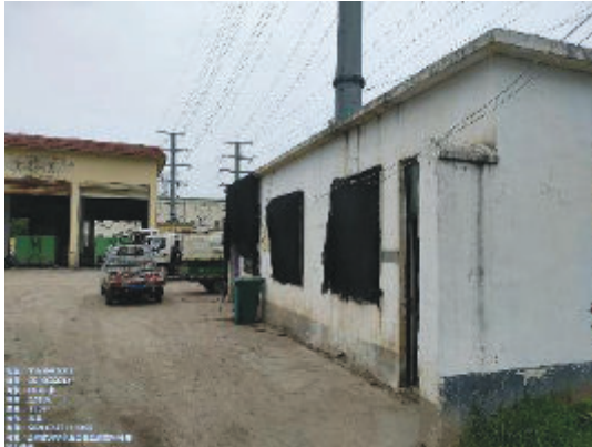
图2-1 110kV金台线2#~3#线下垃圾转运站
