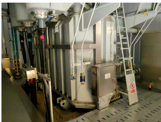
图 4-7 1#主变压器
