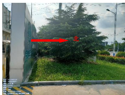
图 4-6 鱼山 110kV 变电站北侧
