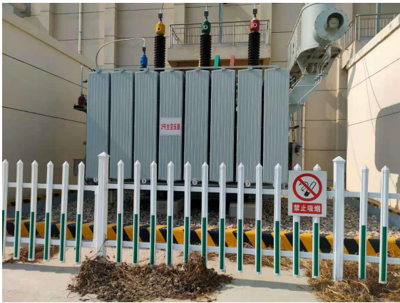
图 4-7 2#主变压器
