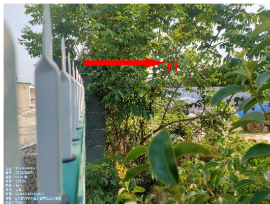
图 4-5 鱼山 110kV 变电站西侧
