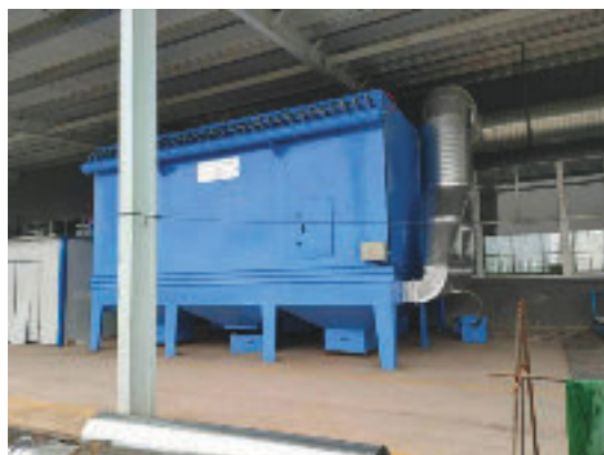
破碎车间油漆废气处理设施
