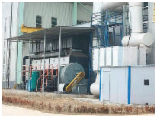
破碎车间油漆废气处理设施
