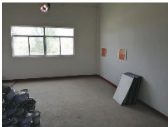
油漆桶暂存区
