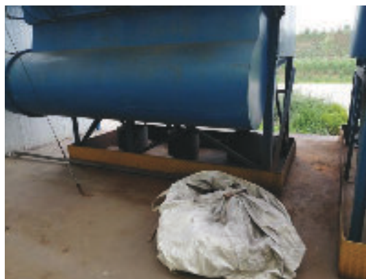
抛丸机、喷砂机收集的粉尘、废钢丸暂存区
