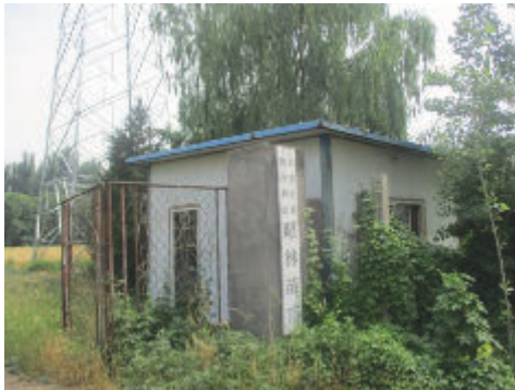
图 2-3 (1) 110kV 茂瑞线 18#-17#线南 10m 园林看护房
