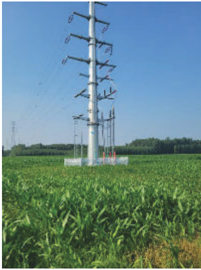
图6-7 电缆沟周围土地恢复情况
