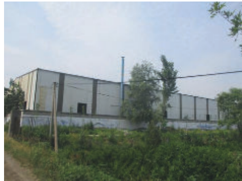
图 2-3 (2) 110kV 茂瑞线 18#-17#线南 28m 工厂
