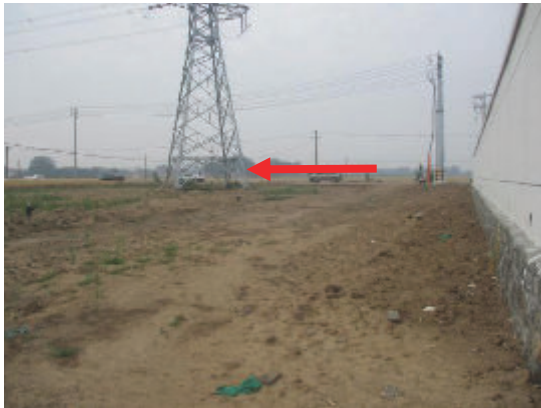
图 4-3 瑞祥 110kV 变电站东侧
