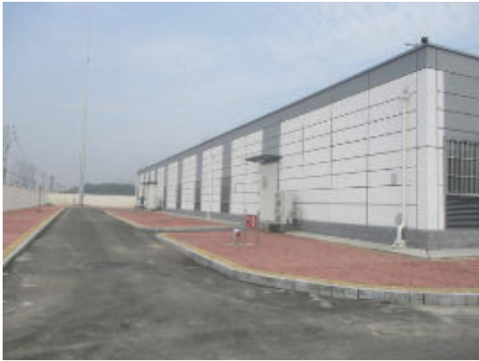
图 \zeta -3 变电站内路面硬化
