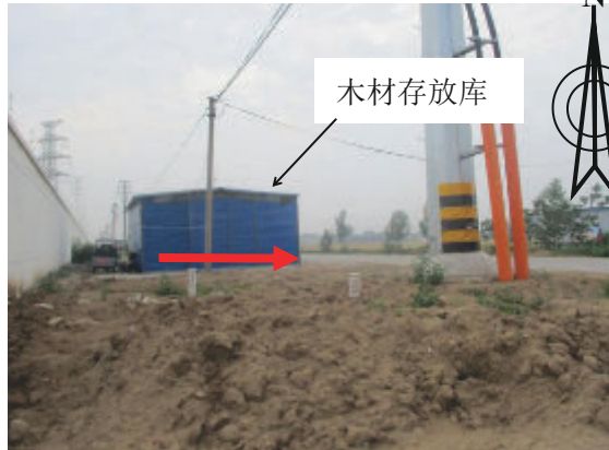
图 4-4 瑞祥 110kV 变电站南侧
