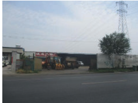
图 2-4 (2) 110kV 茂瑞线 16#-15#线 西 6m 汽修厂
