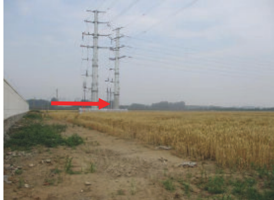
图 4-6 瑞祥 110kV 变电站北侧
