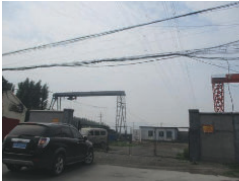
图 2-4 (1) 110kV 茂瑞线 16#-15#线 下跨越汽修厂
