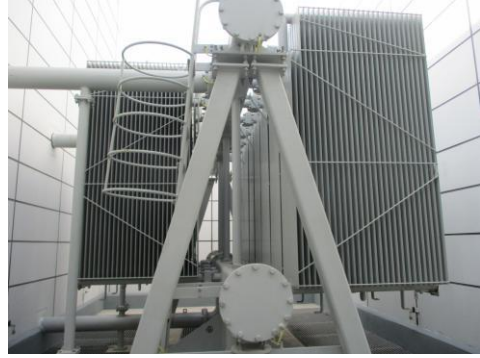
图 4-7 (2) 1#主变压器散热器
