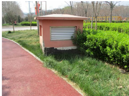
图6-6 电缆沟周围土地恢复
