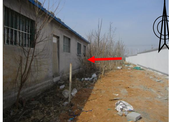
图 4-4 阜新 110kV 变电站南侧
