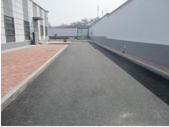
图6-3 变电站内路面硬化
