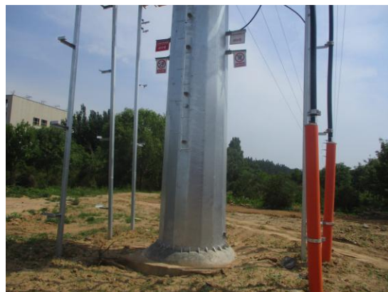
图6-6 塔基周围土地恢复
