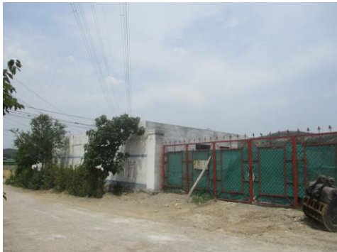
图 2-5 110kV 文崗线/文北线 9-10# 线下工厂
