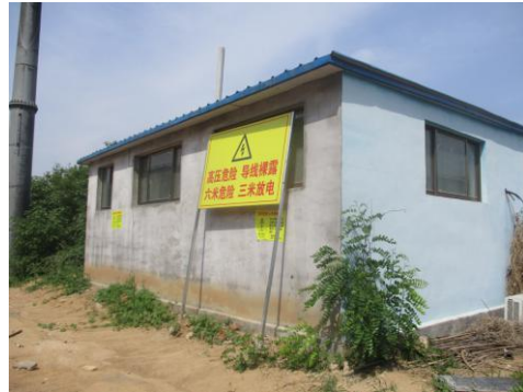
图 2-4 110kV 许北线 10-11#线东 5m 果园看护房
