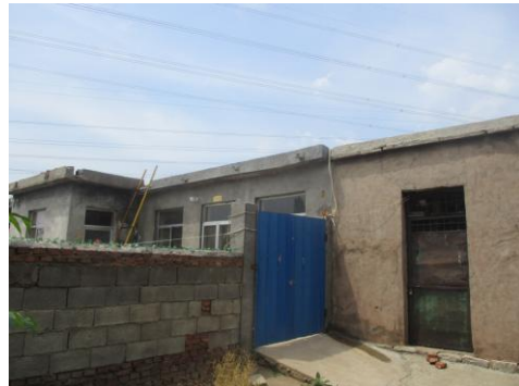
图 2-6 110kV 文崗线/文北线 8-9# 线东南 15m 果园看护房
