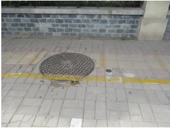
图6-7 电缆沟周围土地恢复
