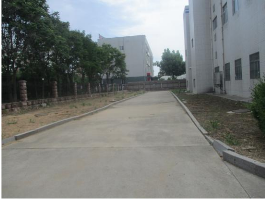
图6-3 变电站内路面硬化
