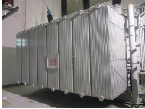
图 4-8 2#主变压器
