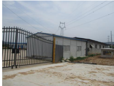
图 2-8 110kV 文崮线/文北线双回电缆，线北 3m，工厂看护房
