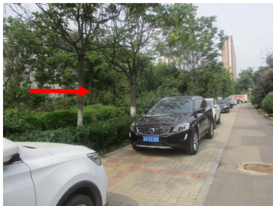
图 4-6 河北 110kV 变电站北侧
