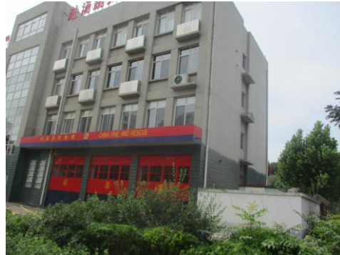
图 2-2 站东 1m, 消防队办公室楼
