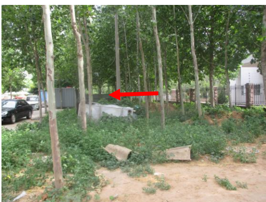
图 4-5 河北 110kV 变电站西侧
