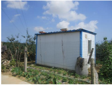
图 2-1 220kV 观铁线 8-9#线西 9m 果园看护房
