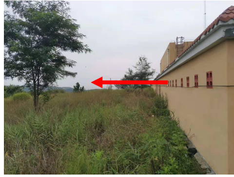
图 4-4 变电站东北侧
