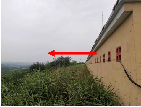
图 4-3 变电站西北侧
