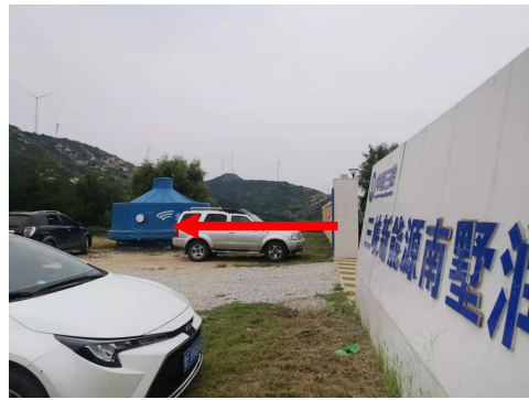
图 4-6 变电站西南侧
