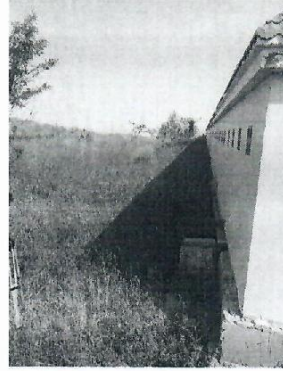
图 2 南墅润莱风电场升压站站址西北侧距围墙 5m 处
