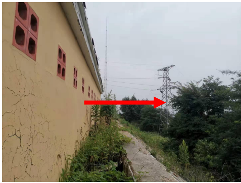
图 4-5 变电站东南侧
