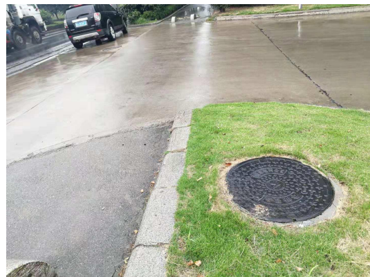
图6-6 电缆沟周围土地恢复
