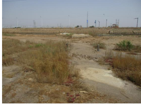
图6-2 电缆沟周围恢复情况
