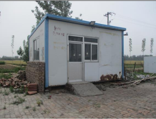
图 2-3 站址南侧 72m 煤炭看护房
