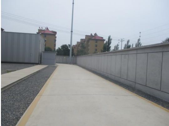
图6-3 变电站内路面硬化
