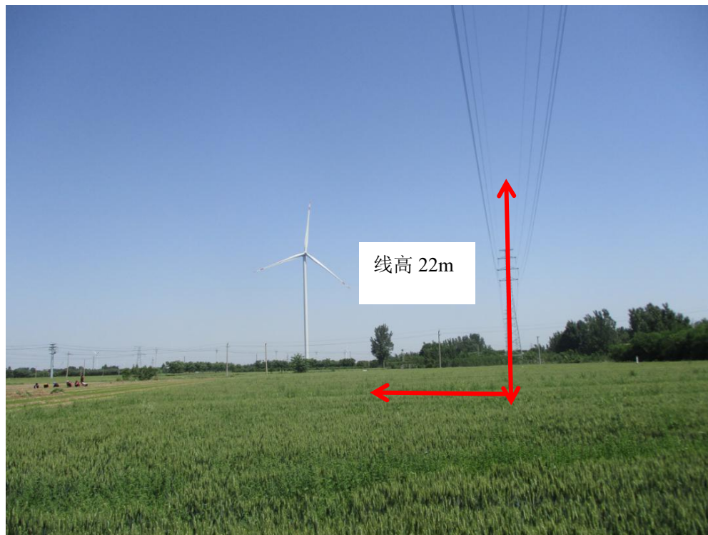
图 7-1 110kV 窑翟线/110kV 窑唐 T 线 5-6#线西衰减，线高 22m
