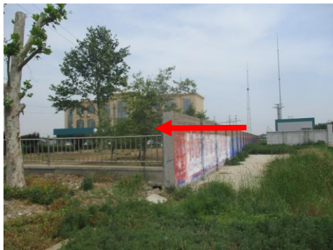
图 4-5 翟王 110kV 变电站西侧
