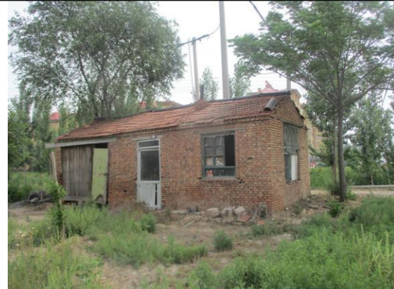
图 2-2 站址南侧 30m, 煤炭看护房
