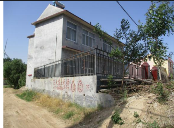
图 2-6 110kV 窑翟线/110kV 窑唐 T 线 13#-12#线西 12m, 民房
