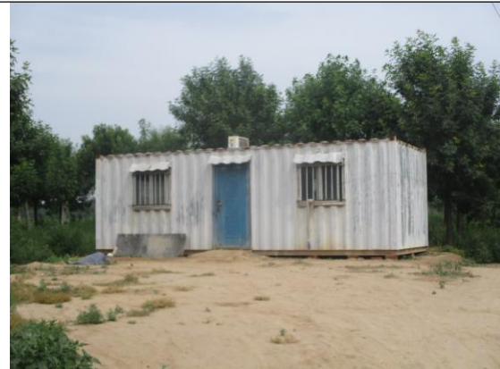
图 2-4 站址北侧 22m 看护房
