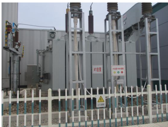
图 4-7 1#主变压器
