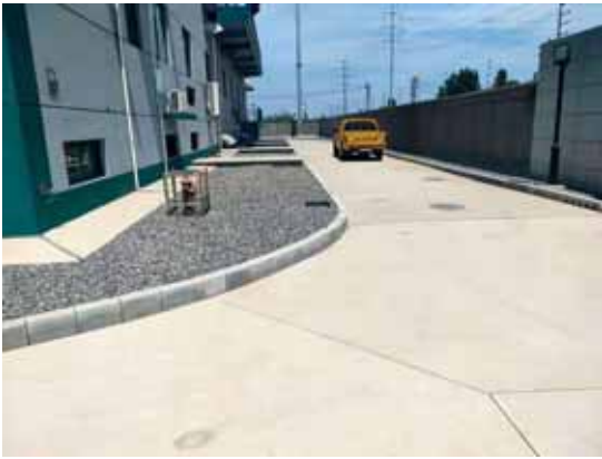
图6-3 变电站内路面硬化
