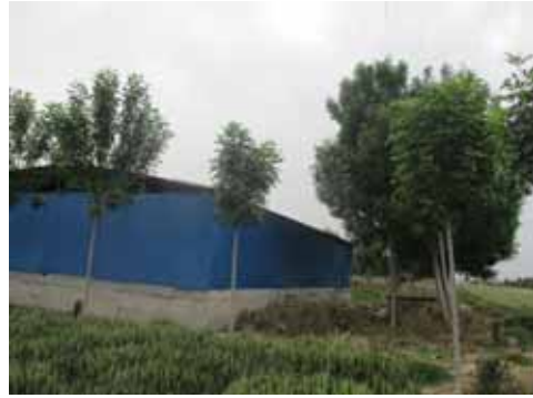
图 2-4 110kV 双坊线 96#-95#线南 2m, 养殖看护房
