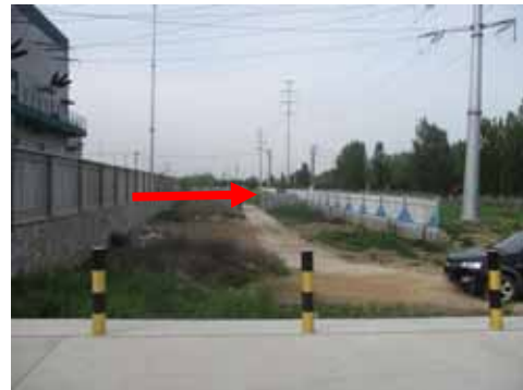
图 4-4 何坊 110kV 变电站东南侧
