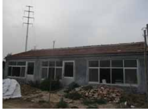
图 2-2 110kV 双坊线/110kV 窑坊线 100#-101#线东北 3m, 看护房
