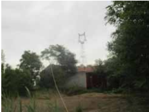
图 2-5 110kV 双坊线 86#-85#线南 25m, 王湾村民房
