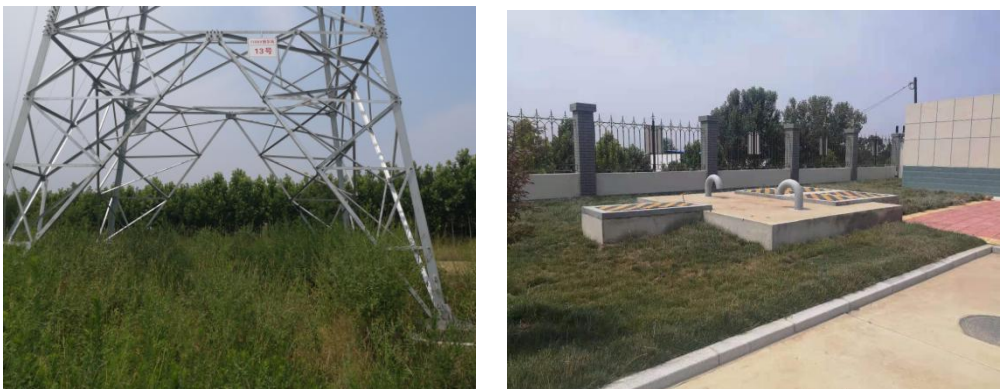
图 6-1 (c) 塔基下方土地复原及变电站绿化情况
