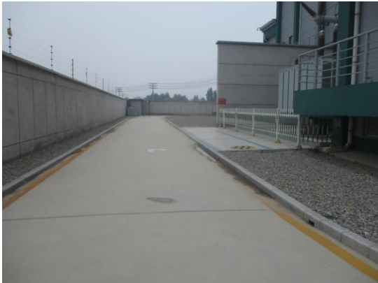
图6-3 变电站内路面硬化
