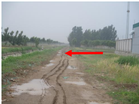
图 4-5 高渡 110kV 变电站西侧
