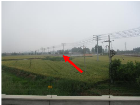
图 4-3 高渡 110kV 变电站东侧
