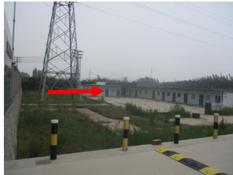
图 4-4 高渡 110kV 变电站北侧
