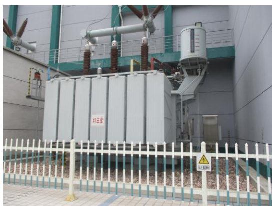
图 4-7 1#主变压器
