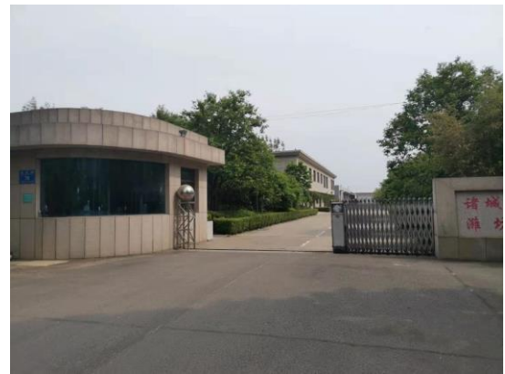
图2-12 110kV涓南线47#-50#线下跨越 诸城市中粮建筑有限责任公司 等5家工厂
