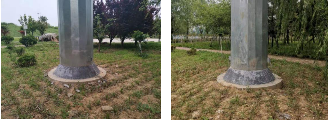
图6-7 生态红线区内塔基周围土地恢复情况
