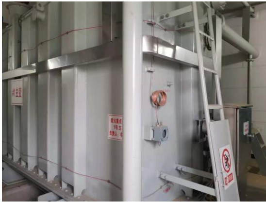
图 4-7 #1 主变压器
