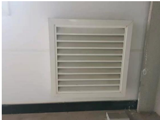
图6-4 110kV 配电装置室通风
