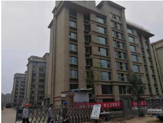
图2-15 110kV栗南线76#-75#线北10m在 建大观朴拙园居民楼
