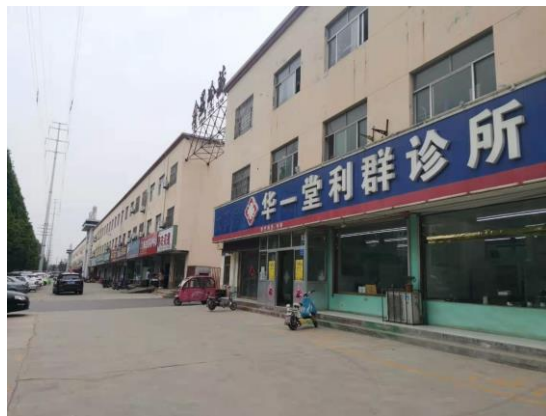
图2-5 110kV涓南线#36-#39线南9m沿街楼
