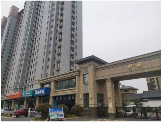
图2-3 110kV涓南线#33-#34线南27m桂园小区
