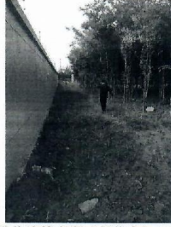
图 1-2 潍坊诸城南湖（超然台）110kV 变电站东侧厂界外 1m 处
