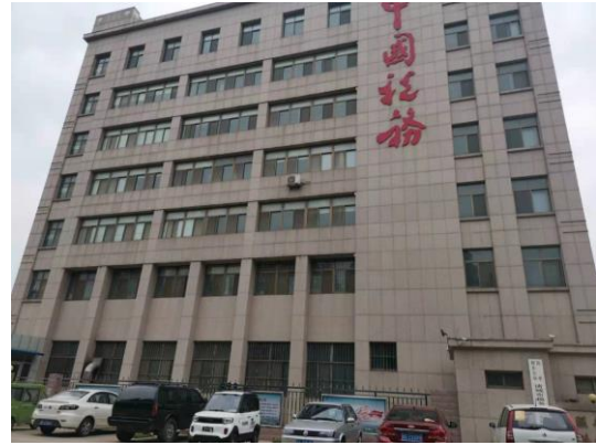
图2-8 110kV涓南线#42-#43线南16m诸 城税务局龙都分局
