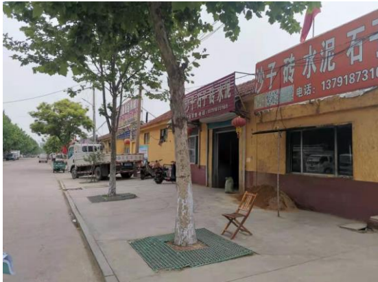
图2-9 110kV涓南线#43-#44线南13m沿 街房
