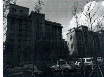
图 2-14 110 kV 栗南线 76#-75#线北 10m 在建大观朴拙园居民楼 (8F)
