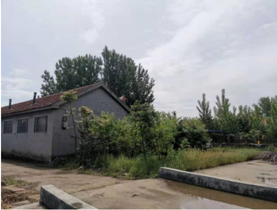
图2-3 110kV涓王线#58-#57线东24m民房
