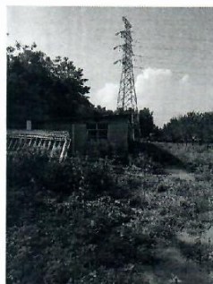
图 2-20 110kV 渭王线 3#-2#线北 10m 看护房
