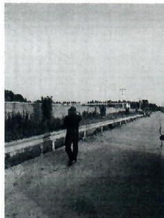
图 2-2 110kV 涓王线 60#-59#线 东 24m 工厂厂房
