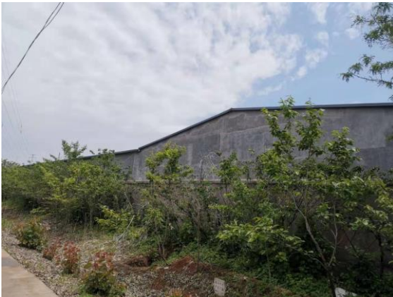
图2-5 110kV涓王线#54-#53线东13m工厂厂房
