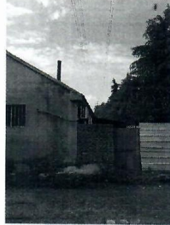
图 2-14 110kV 涓王线 19#-17#线下 5 家养殖场
