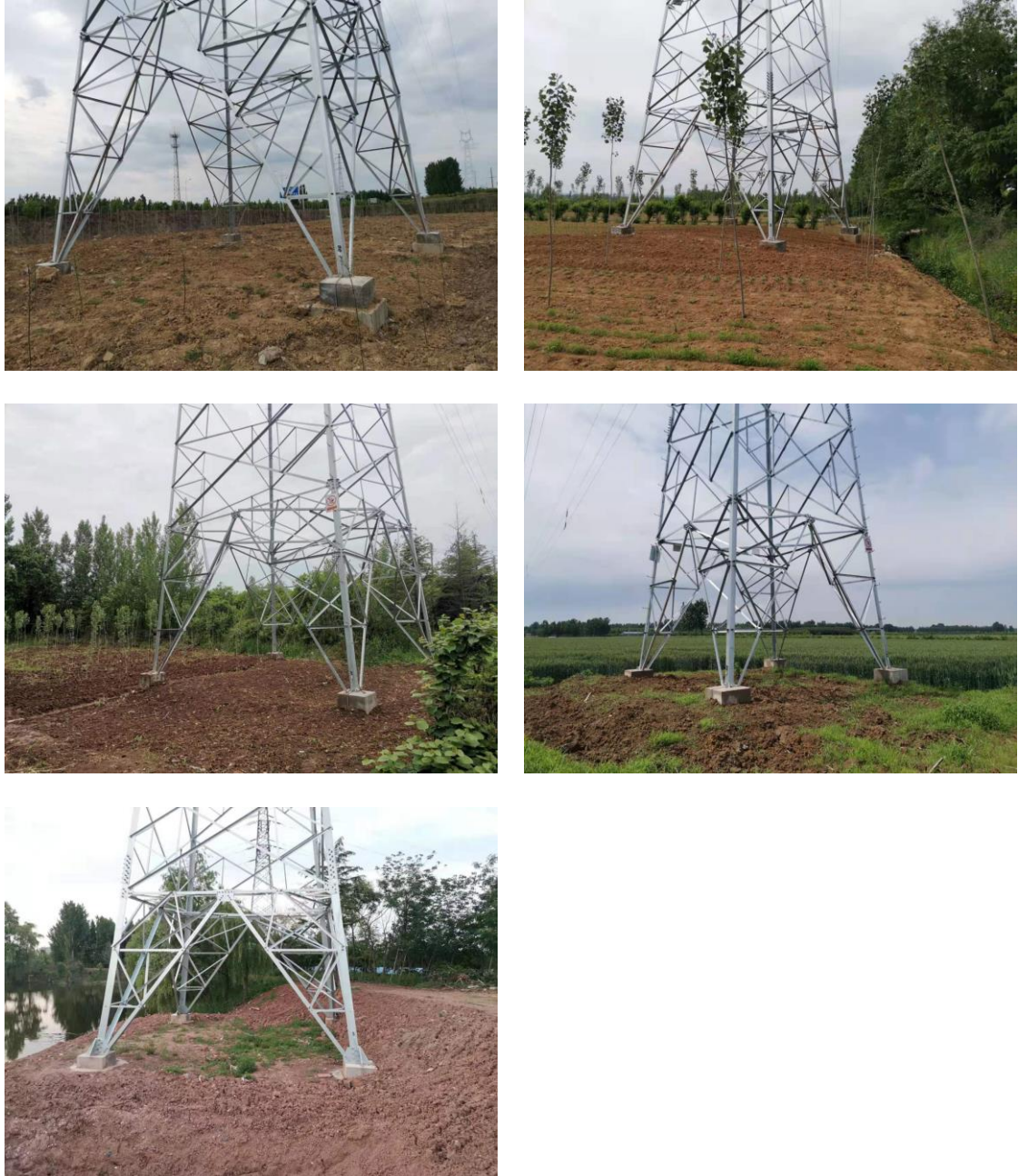
图6-7 生态红线区内塔基周围土地恢复情况
