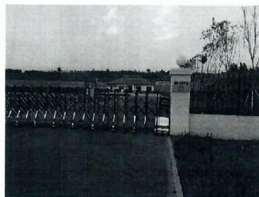
图 2-22 110kV 栗王线 24#-22#线东 15m 密州公路驿站
