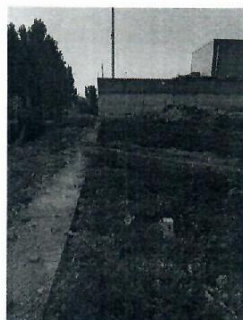
图 2-23 110kV 渭王线/110kV 栗王线双回电缆段
