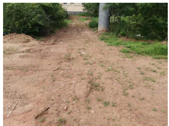
图6-6 电缆沟上方土地恢复情况
