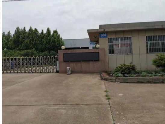
图2-10 110kV涓王线#39-#37线南5m工厂
