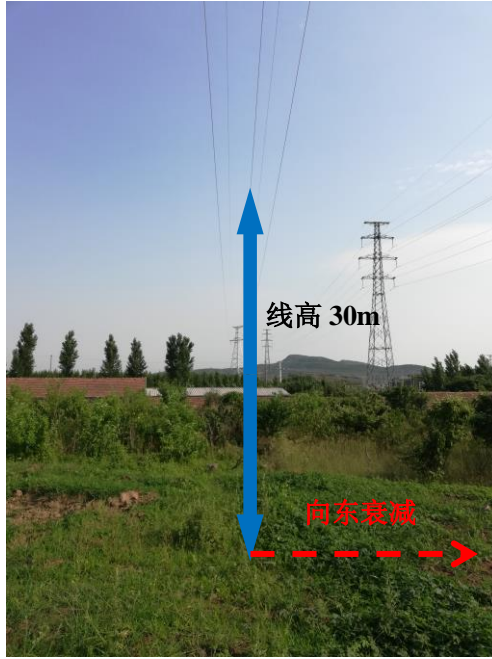
图 7-5 110kV 栗王线单回架空线路衰减断面
