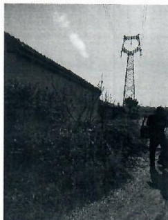
图 2-19 110kV 渭王线 7#-6#线下 3 家养殖场
