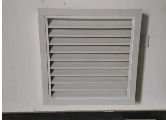
图6-4 110kV 配电装置室通风
