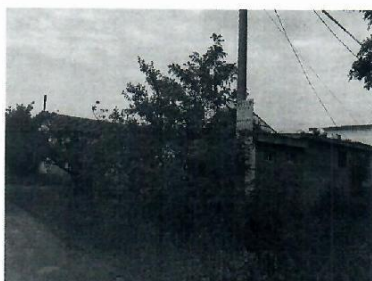
图 2-9 110kV 渭王线 44#-43#线北 23m 民房
