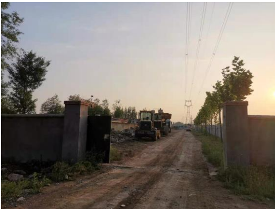
图2-17 110kV涓王线7#-6#线下跨越工厂
