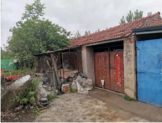
图2-1 110kV涓王线#65-#64线下养殖场看护房
