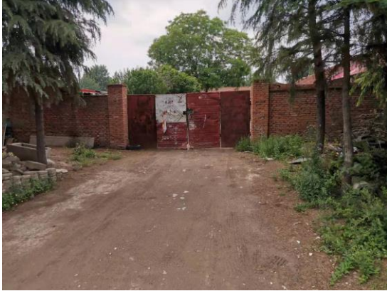
图2-13 110kV涓王线19#-17#线下跨越养殖场看护房
