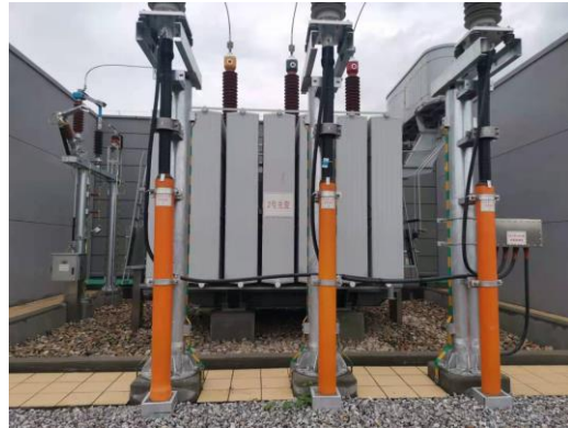
图 4-8 #2 主变压器
