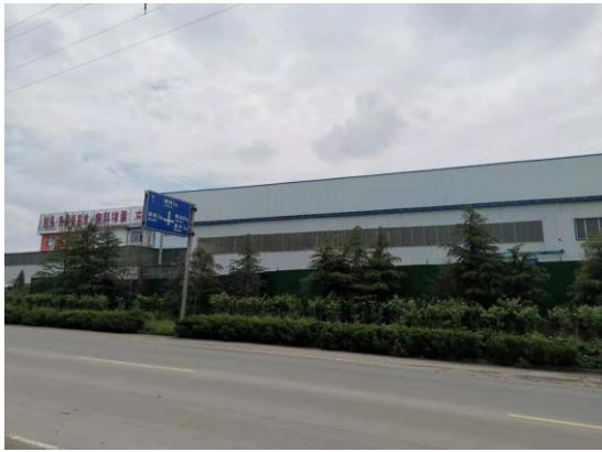
图2-9 110kV涓王线#40-#39线下跨越工厂厂房
