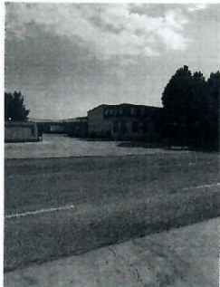
图 2-17 110kV 涓王线 16#-13#线南 5m 友华冷藏 等 3 家企业
