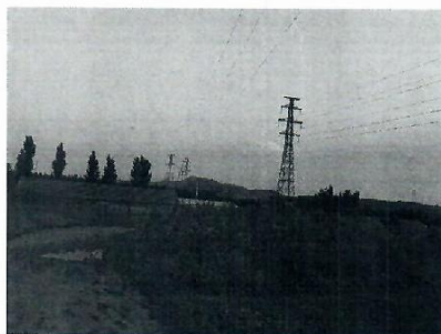
图 2-21 110kV 栗王线 25#-24#线下养殖场
