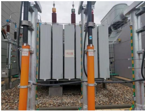
图 4-7 #1 主变压器
