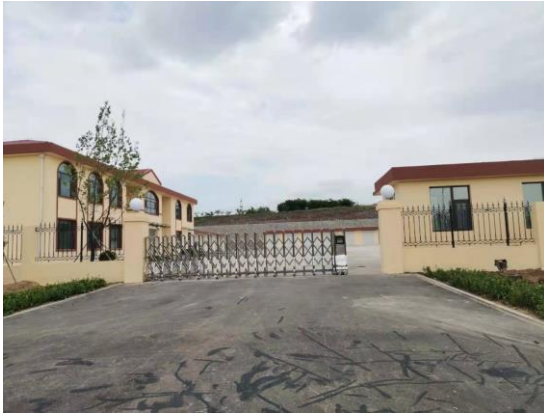
图2-21 110kV栗王线24#-22#线东15m密州公路驿站
