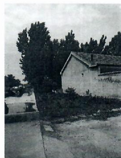
图 2-3 110kV 涓王线 57#-58#线 东 24m 民房
