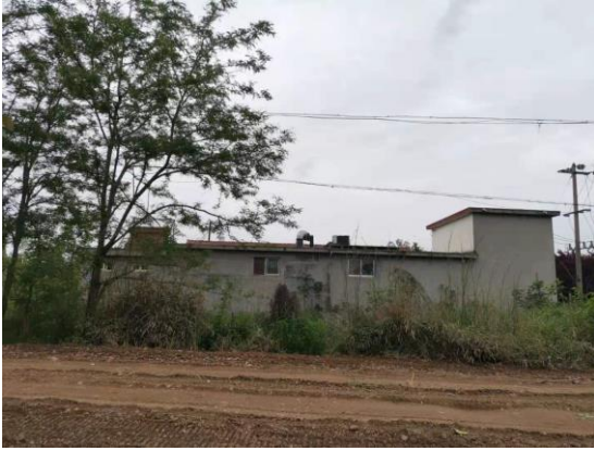
图2-7 110kV涓王线#44-#43线北23m民房
