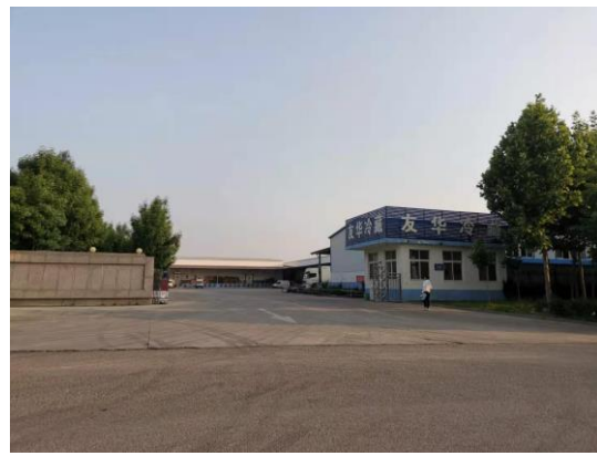
图2-16 110kV涓王线16#-13#线南5m友华冷藏
