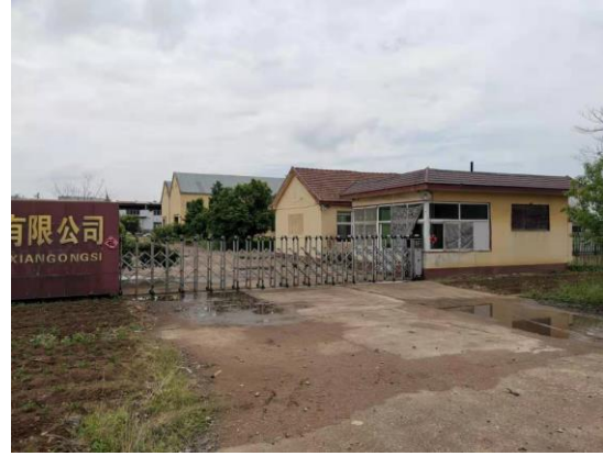
图2-8 110kV涓王线#42-#41线南4m诸城市法斯特建筑节能科技公司
