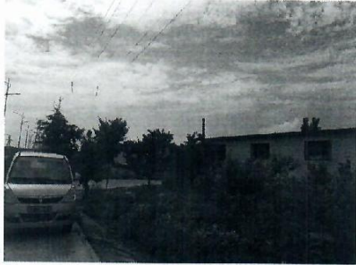
图 2-13 110kV 涓王线 23#-22#线下废品收购站
