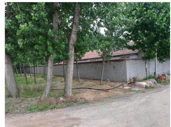
图2-6 110kV涓王线#49-#48线南25m民房
