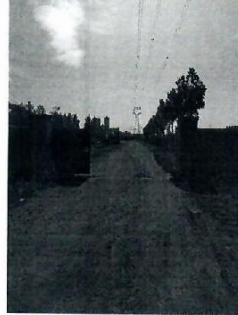
图 2-18 110kV 涓王线 7#-6#线下工厂
