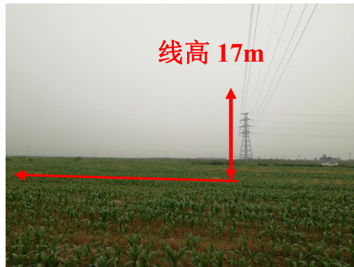
图 7-4 衰减断面②：110kV 罗井线与备用线路 35#-36#之间，向南衰减
