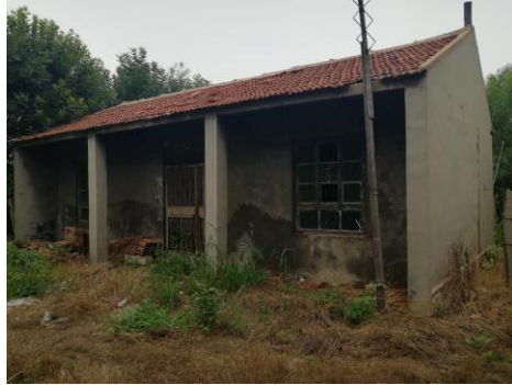
图 2-1 110kV 董井线与备用线路 6#-7#线北 23m 闲置看护房 M2
