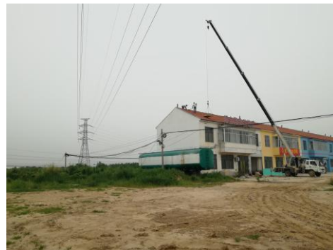
图 2-5 110kV 董井线与备用线路 55#-56#线东南 5mS340 沿街商铺 M6
