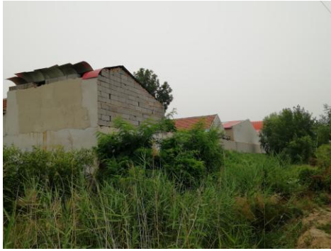
图 2-6 110kV 董井线与备用线路 56#-57#线西北 3m 工厂厂房 M7
