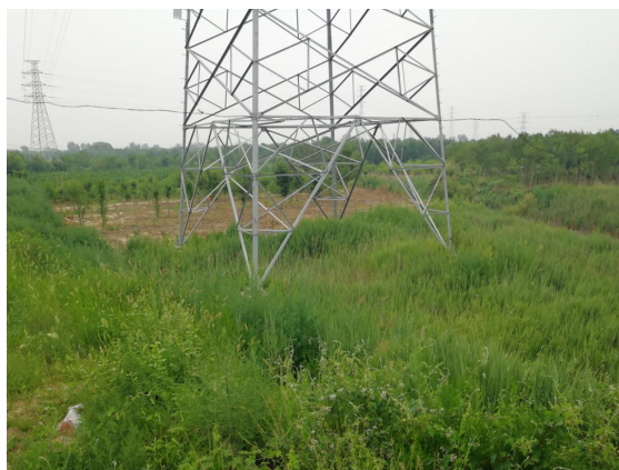
图6-1 塔基周围恢复情况
