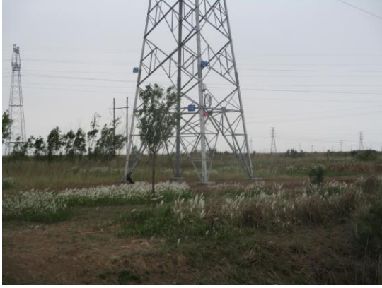
图6-1（1） 塔基周围土地恢复情况
