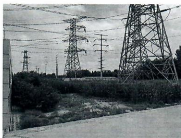
图 2 潍坊宋庄 220kV 变电站站址南侧距围墙 5m 处
