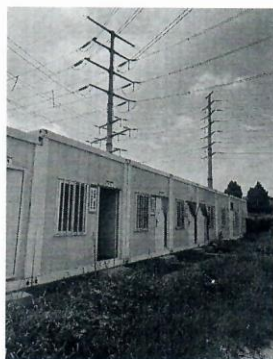
图 5 潍坊宋庄 220kV 变电站站址东南侧 30m 看护房
