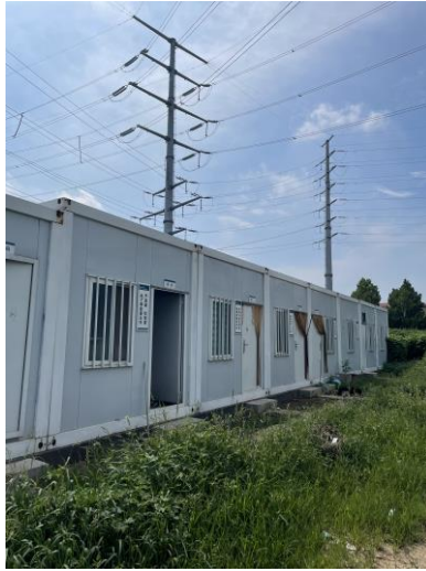
图2-1 变电站东南侧30m处看护房
