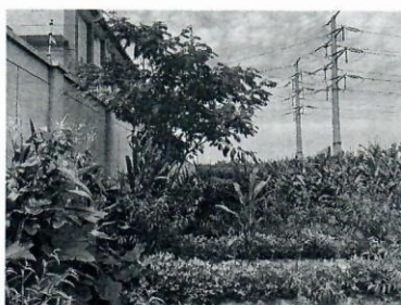
图 4 潍坊宋庄 220kV 变电站站址北侧距围墙 5m 处
