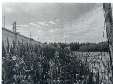
图 3 潍坊宋庄 220kV 变电站站址西侧距围墙 5m 处
