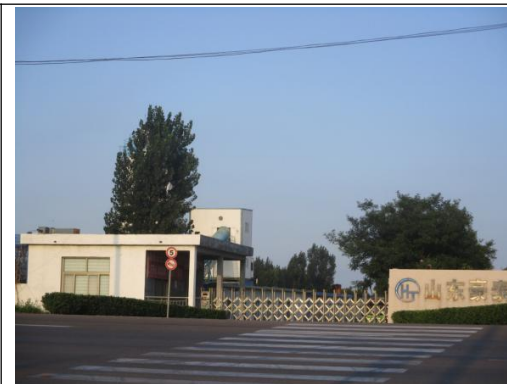
图 2-9 110kV 湖滨线 29#-30#/110kV 信园线 27#-26#线东 10m 山东豪泰建材公司传达室
