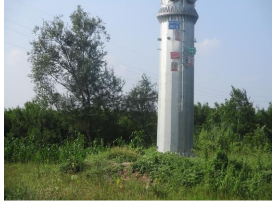
图6-1（2） 塔基周围恢复情况
