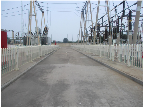
图6-3 变电站内路面硬化
