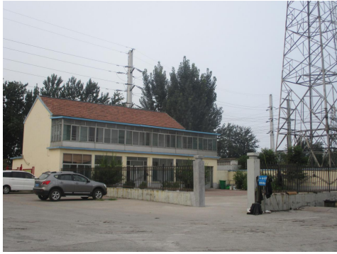
图 2-3 变电站西北侧 1m，邹平德润物流公司办公楼
