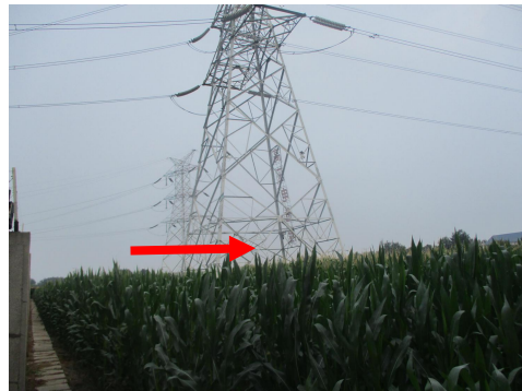
图 4-4 肖镇 220kV 变电站南侧
