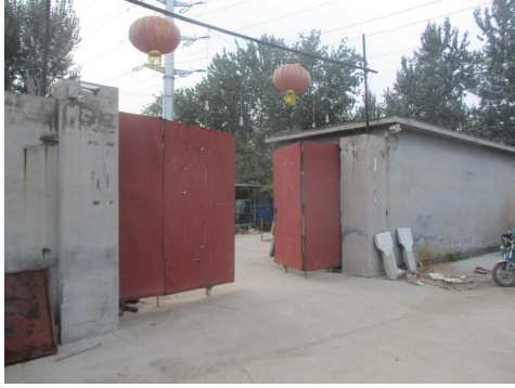
图 2-1 变电站北侧大门西侧 1m，村民房
