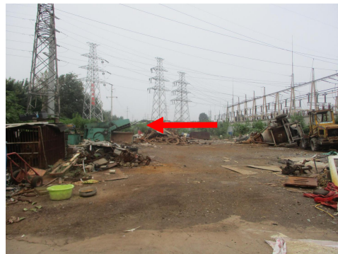
图 4-6 肖镇 220kV 变电站北侧
