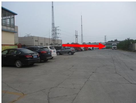
图 4-5 肖镇 220kV 变电站西侧
