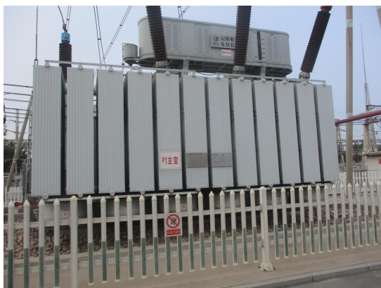
图 4-7 1#主变压器
