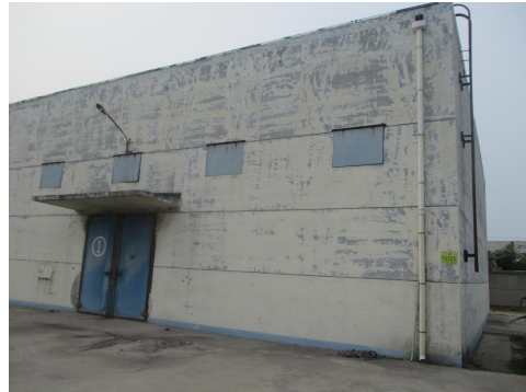
图 2-6 变电站南侧 1m，大地育种公司厂房
