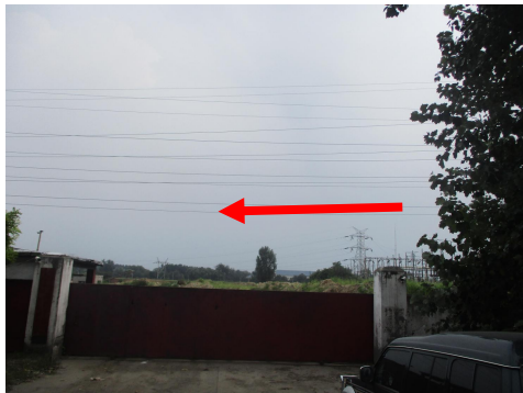
图 4-3 肖镇 220kV 变电站东侧
