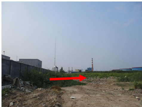
图 4-3 成达 110kV 变电站东侧
