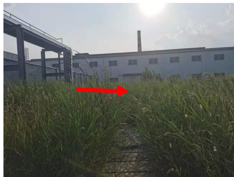
图 4-6 成达 110kV 变电站北侧
