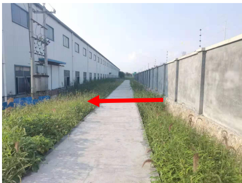
图 4-5 成达 110kV 变电站西侧
