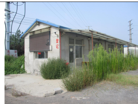
图 2-3 110kV 锦成 I 线、II 线双回电缆线上闲置看护房
