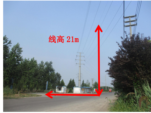
图 7-2 110kV 锦城 I 线 41#-42#/110kV 锦 城 II 线 41#-42#线西北衰减
