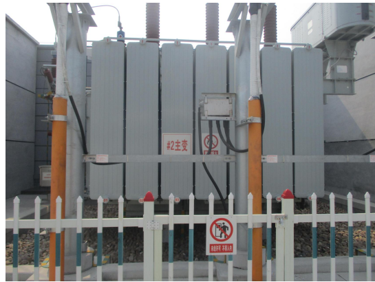
图 4-8 2#主变压器
