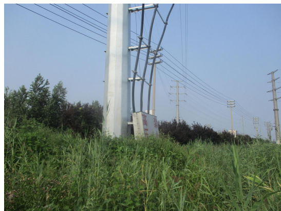
图6-6 塔基周围土地恢复
