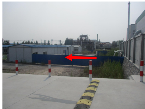
图 4-4 成达 110kV 变电站南侧
