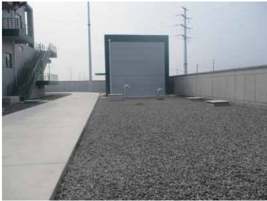
图6-3 变电站内路面硬化
