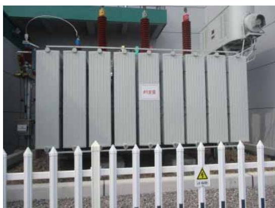
图 4-7 1#主变压器
