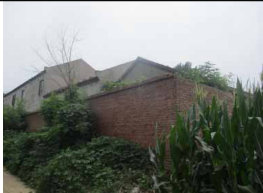
图 2-10 110kV 肖崔 T 线 41#-42#/110kV 范崔 T 线 17#-18#线东 17m 鲁丰面粉厂西侧厂房
