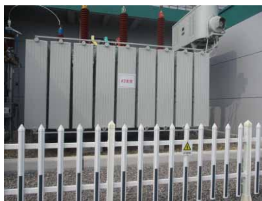
图 4-8 2#主变压器
