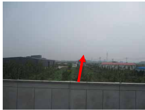
图 4-4 苑城 110kV 变电站南侧
