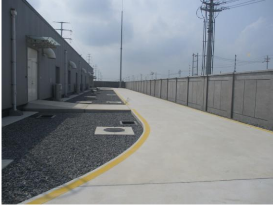
图6-3 变电站内路面硬化
