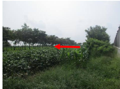
图 4-4 蔡古 110kV 变电站南侧
