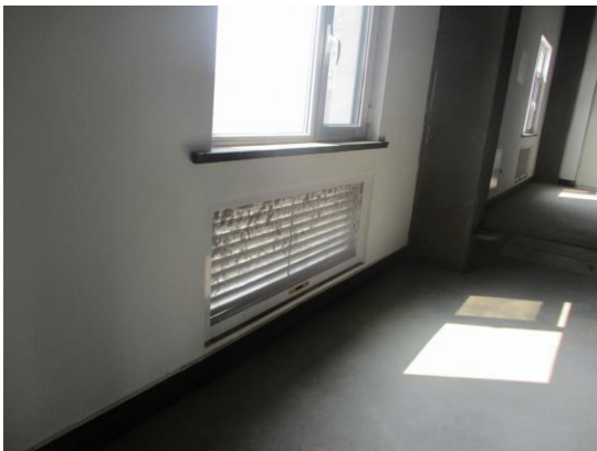
图6-5 110kV 配电室通风
