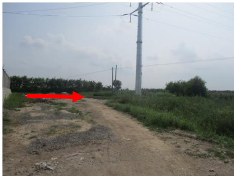
图 4-5 蔡古 110kV 变电站西侧
