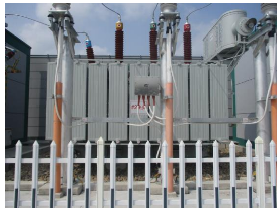
图 4-8 2#主变压器
