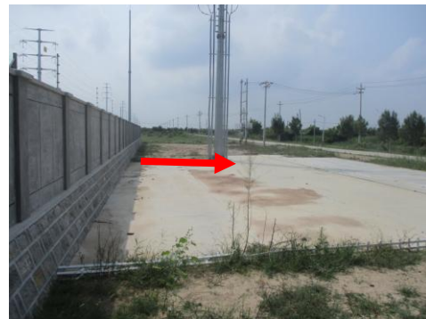
图 4-6 蔡古 110kV 变电站北侧
