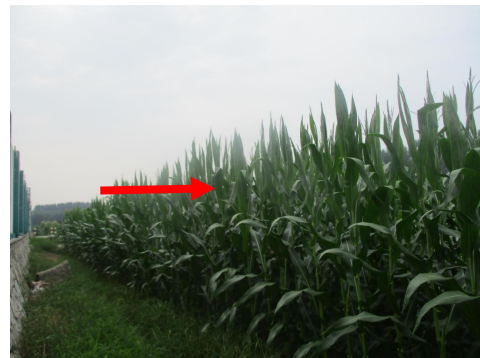
图 4-4 明集 220kV 变电站北侧
