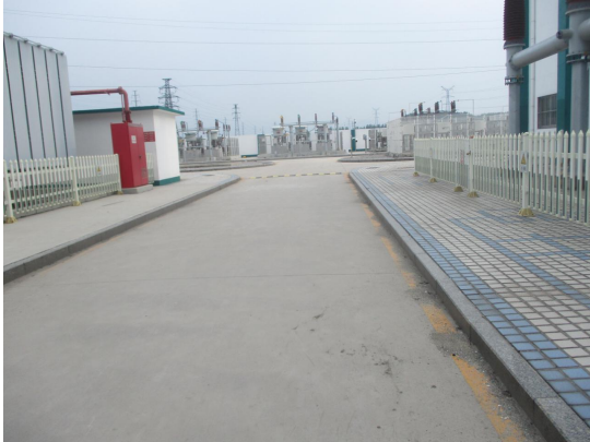
图6-3 变电站内路面硬化
