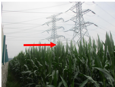
图 4-5 明集 220kV 变电站西侧
