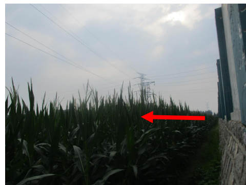
图 4-6 明集 220kV 变电站南侧
