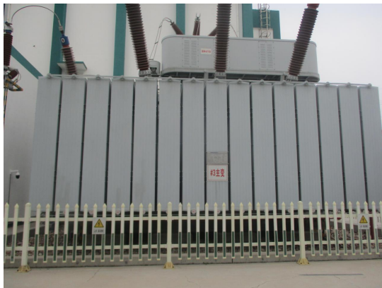
图 4-7 3#主变压器
