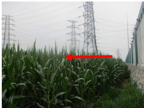
图 4-3 明集 220kV 变电站东侧
