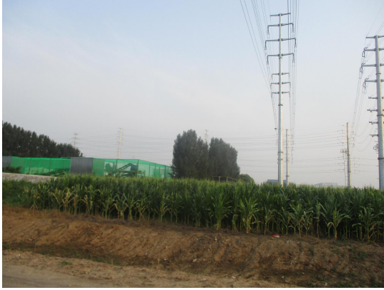
图6-1（1） 塔基周围恢复情况
