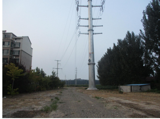
图6-1（2） 塔基周围恢复情况
