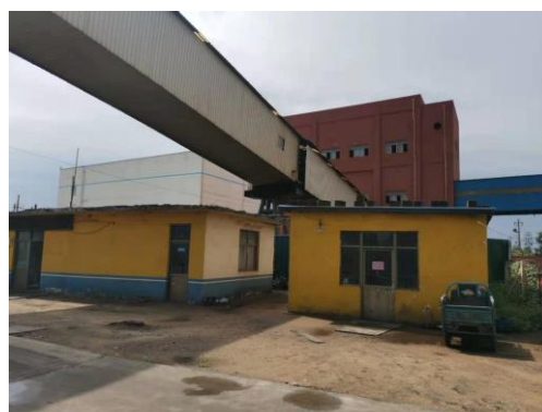
图2-4 220kV左钢线8#-9#线东11m检修站
