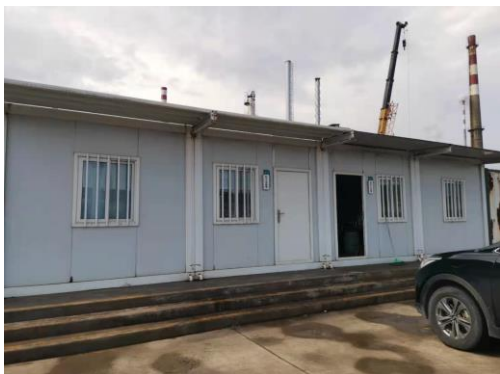
图2-1 变电站东侧20m项目部
