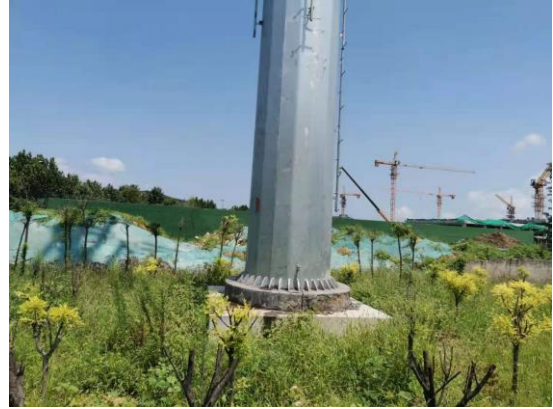
图6-8 塔基周围土地恢复情况
