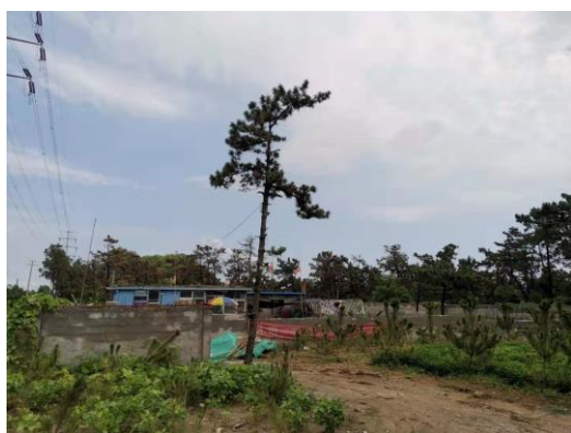
图2-5 220kV左钢线8#-9#线东14m看护房
