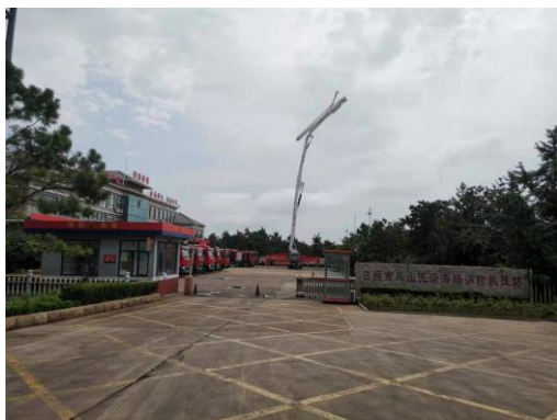
图2-3 220kV左钢线6#-7#线东11m日照市岚山区沿海路消防救援站警卫室
