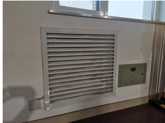
图6-4 配电装置室内通风
