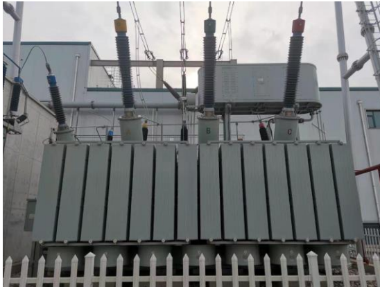
图 4-7 #1 主变压器
