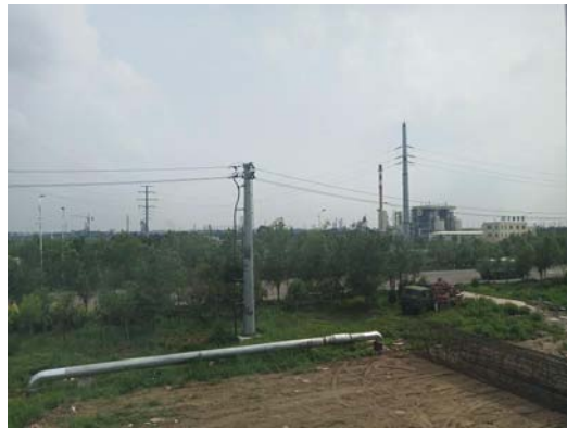
图 4-4 兴东 110kV 变电站南侧
