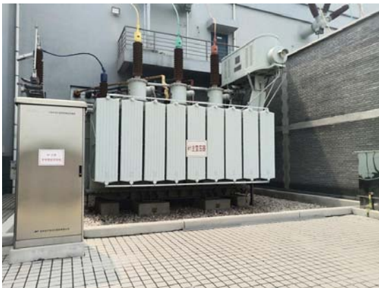
图 4-7 1#主变压器
