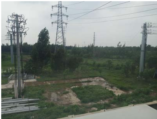
图 4-5 兴东 110kV 变电站西侧
