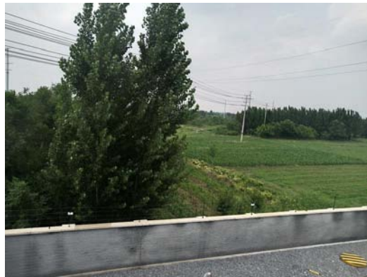
图 4-6 兴东 110kV 变电站北侧
