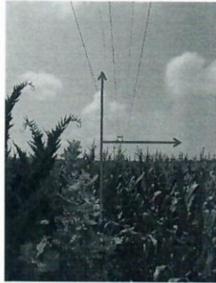
图 1 110kV 镇赵线 94#-95#杆塔之间, 向北侧衰减
