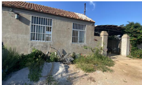
图2-21 110kV镆赵线101#~102#塔间线路东侧23m养殖看护房
