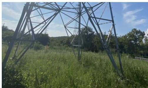
图6-15 塔基处植被恢复
