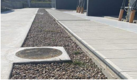
图6-1 变电站内路面硬化
