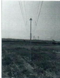
图 3 110kV 石赵线 53#-54#/110kV 镇赵线 83#-84#杆塔之间, 向西北侧衰减
