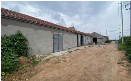
图2-19 110kV镆赵线83#~84#塔间线路西 侧10m禽业养殖场2户看护房
