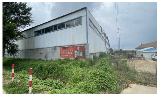
图2-12 110kV 镆赵线71#~72#塔间线路南侧4m金平鱼粉厂
