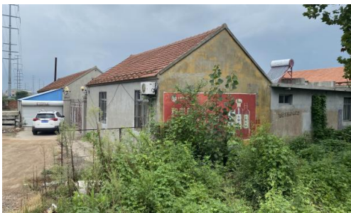
图2-11 110kV 镆赵线72#~73#塔间线路北侧7m海鲜加工厂
