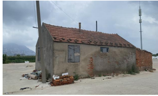
图2-18 110kV镆赵线80#~81#塔间线路南 侧15m海带加工坊厂房
