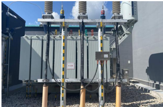
图 4-7 1#主变压器
