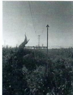
图 5 110kV 镇赵线/110kV 莫玄线 1#-2#杆塔向西侧衰减
