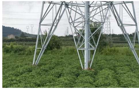
图6-12 塔基处植被恢复
