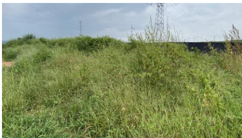
图6-7 电缆沟处植被恢复
