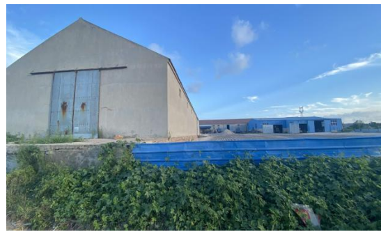
图2-20 110kV镆赵线92#~93#塔间线路南 侧19m肥料厂厂房
