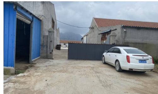
图2-16 110kV 镆赵线79#~80#塔间线路线下饲料加工厂房
