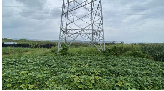
图6-10 塔基处植被恢复
