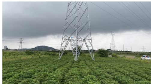
图6-8 塔基处植被恢复
