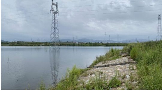
图6-9 穿越八河水库生态保护红线区现状
