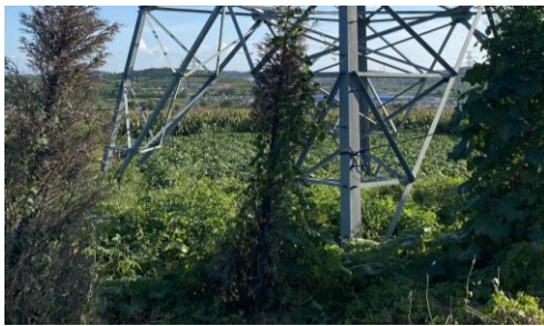
图6-13 塔基处植被恢复
