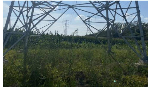
图6-14 塔基处植被恢复
