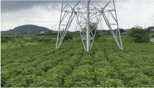
图6-11 塔基处植被恢复
