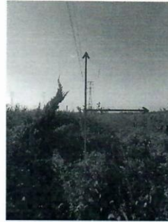
图 2 110kV 靖海线 13#-14#杆塔之间, 向南侧衰减
