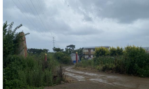
图2-6 110kV 漠赵线55#~56#塔间线路东侧 16m丽山香泉砖房
