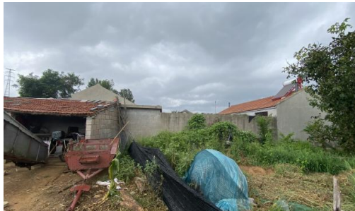
图2-7 110kV 漠赵线62#~63#塔间线路北侧 25m养猪场看护房
