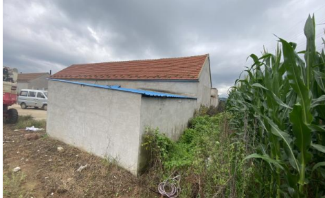
图2-5 110kV 漠赵线56#~57#塔间线路东侧 25m养猪场看护房
