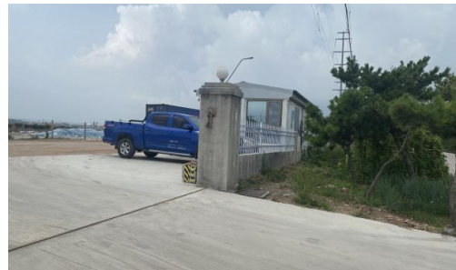
图2-14 110kV 镆赵线78#~79#塔间线路线下海鲜加工看护房门卫房
