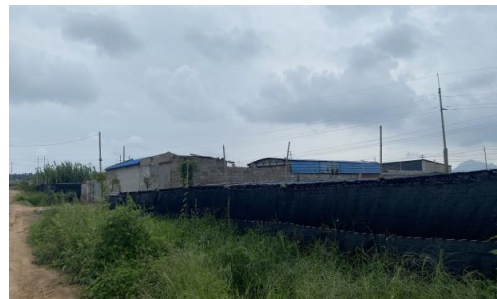
图2-8 110kV 漠赵线65#~66#塔间线路东侧 28m民房
