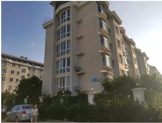
图2-1 110kV文龙线8#-10#线西15m银海绿洲小区居民楼
