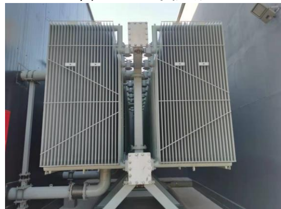
图 4-10 主变散热器
