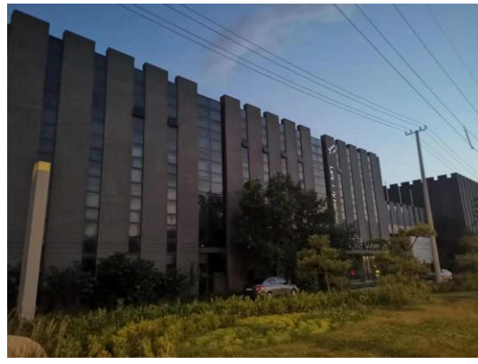
图2-12 110kV文龙线31#-32#线南20m悠港商业楼
