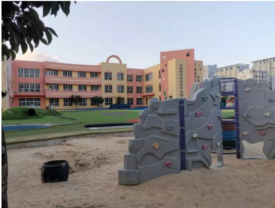
图2-5 110kV文龙线16#-17#线东24m文登开发区中心幼儿园 (3F) (5F)
