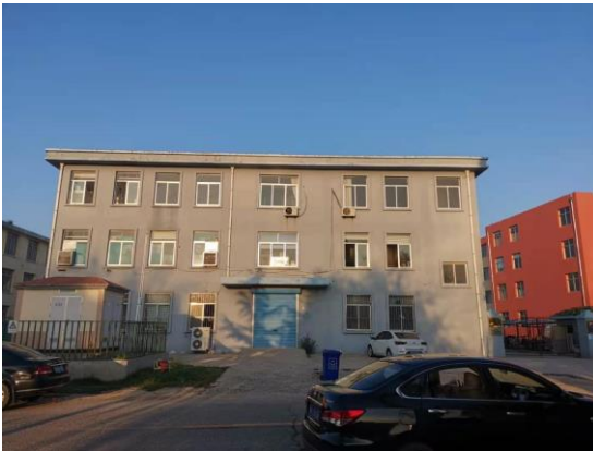
图2-3 110kV文龙线14#-15#线东30m文登世进电子有限公司
