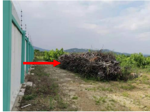
图 4-4 变电站东北侧
