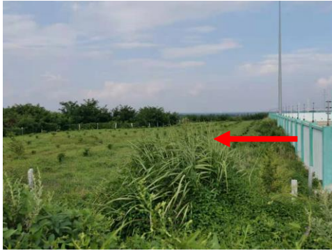
图 4-3 变电站西北侧
