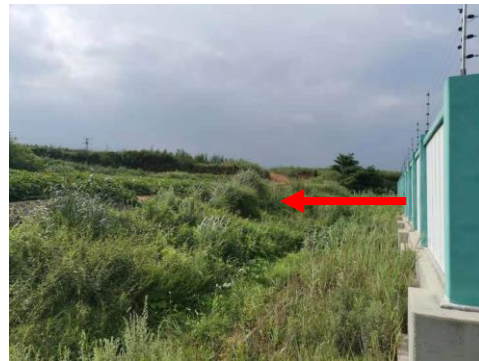
图 4-6 变电站西南侧
