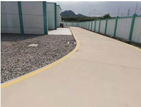
图6-5 路面硬化
