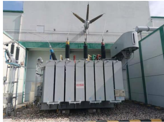
图 4-8 #2 主变压器
