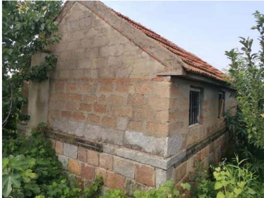
图2-7 110kV车金线54#-55#线南16m养殖看护房4
