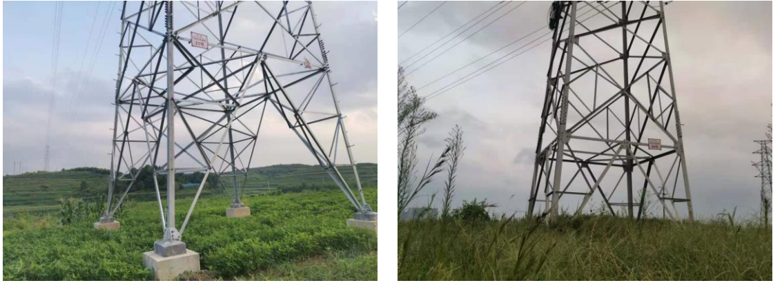
图6-1 塔基周围土地恢复情况
