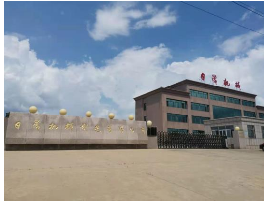
图2-34 110kV车金线93#-94#线北5m日晟机械制造有限公司
