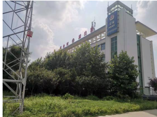
图2-16 110kV车金线68#-70#线南20m乳山市热力集团
