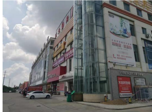
图2-26 110kV车金线84#-85#线西26m 汇美嘉家居广场
