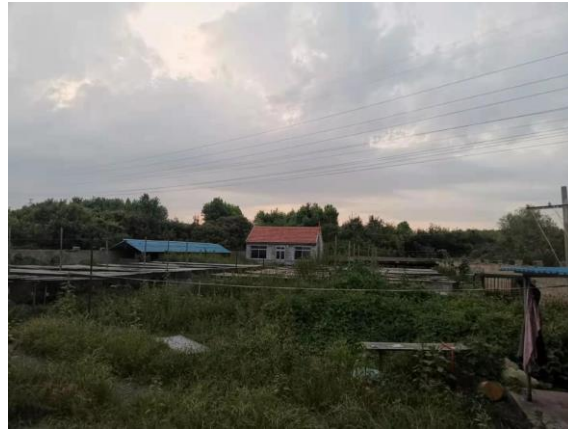
图2-4 110kV车金线45#-46#线下跨越养殖场看护房3
