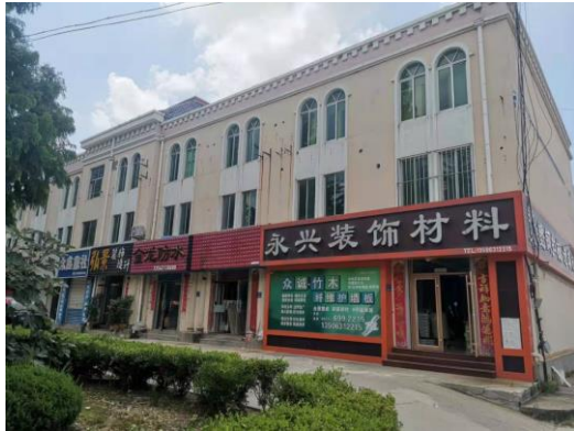
图2-25 110kV车金线82#-83#线西18m 永兴装饰材料等沿街商铺
