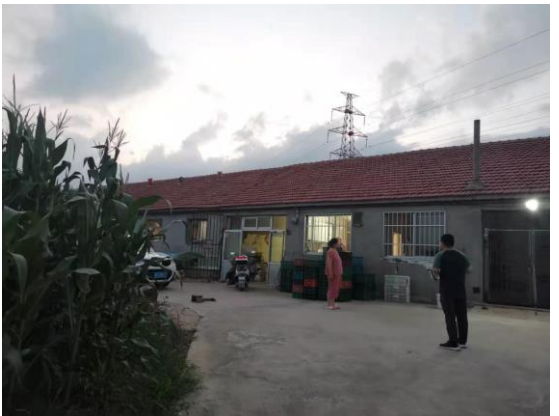
图2-5 110kV车金线46#-47#线下跨越民房
