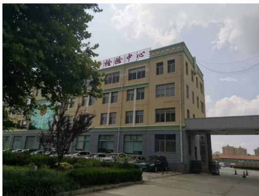
图2-11 110kV车金线62#-63#线南20m山东省农副产品监督检验中心及沿街楼房
