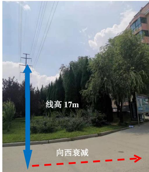
图 7-3 110kV 车金线升压段线路衰减断面
