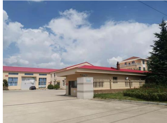
图2-32 110kV车金线92#-93#线北5m苍煌农业发展有限公司
