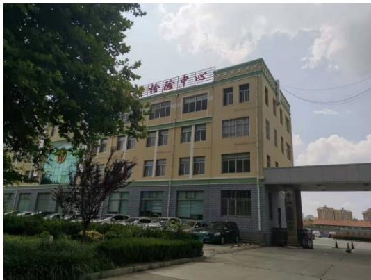
图2-17 110kV车金线70#-72#线西20m光明小区及沿街商铺（6F）
