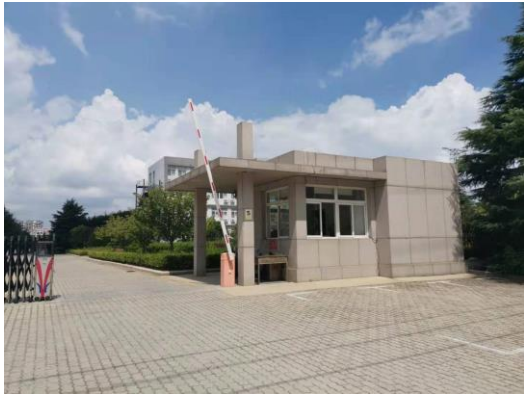
图2-31 110kV车金线90#-91#线北5m金聚粉末冶金公司
