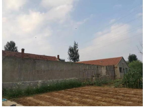
图2-2 110kV车金线19#-20#线西11m养殖场看护房1
