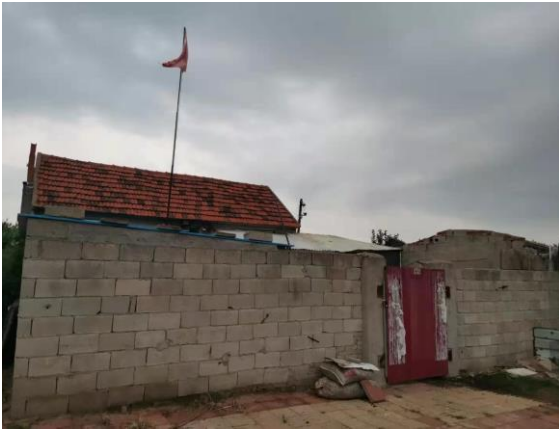
图2-3 110kV车金线45#-46#线下跨越养殖场看护房2
