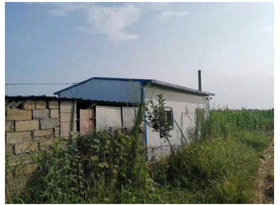
图2-6 110kV车金线50#-51#线北5m大棚看护房
