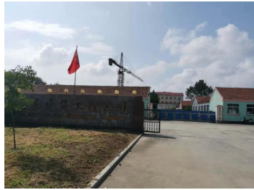
图2-14 110kV车金线64#-65#线南20m北京华钜津桥联合商务有限公司、汽车维修及沿街商铺
