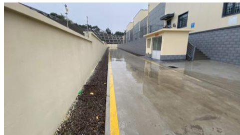
图6-8 变电站内路面硬化
