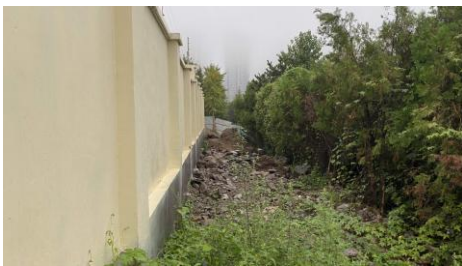
图6-7 电缆沟处植被恢复
