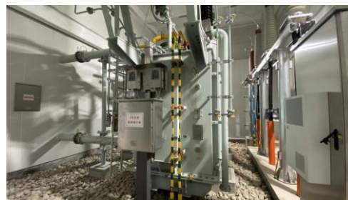
图 4-8 2#主变压器
