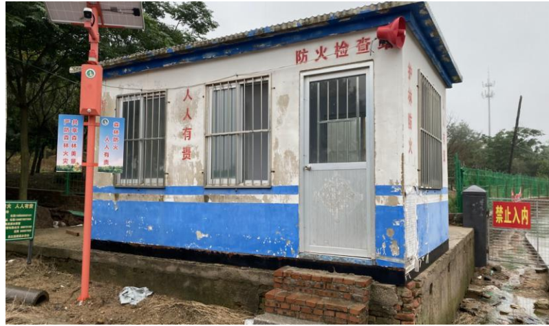
图2-1 110kV江山南变电站西南侧29m林地防火检查站
