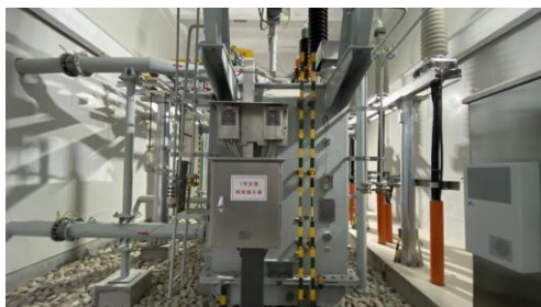
图 4-7 1#主变压器
