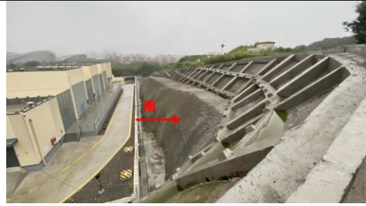
图 4-4 江山南 110kV 变电站南侧
