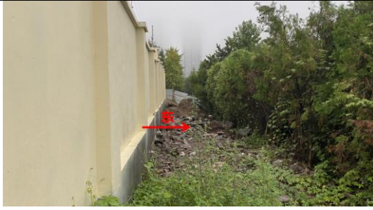
图 4-3 江山南 110kV 变电站东侧
