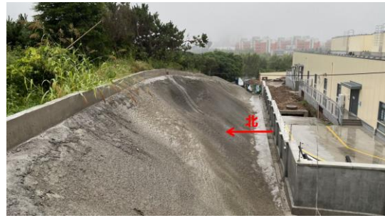
图 4-6 江山南 110kV 变电站北侧
