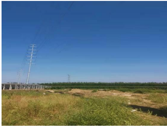
图6-3 临时占地周围恢复情况
