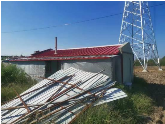
图 2-4 110kV 凤洪线 16#-17#/110kV 沙湾线 16#-17#线下跨越看护房
