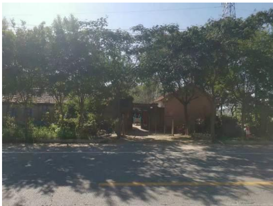
图 2-6 110kV 凤洪线 25#-26#/110kV 沙湾线 25#-26#线下跨越看护房
