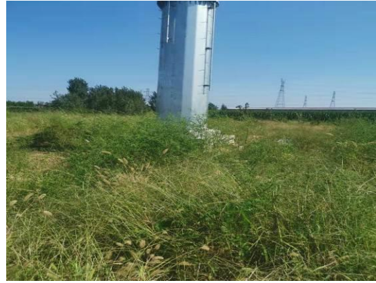
图6-2 110kV 凤洪线10#/110kV 沙湾线10#杆塔下方植被恢复情况
