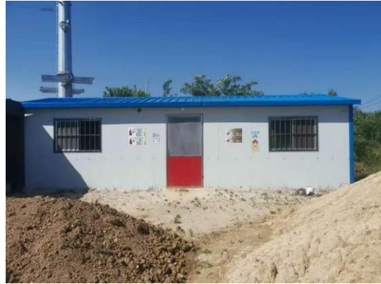
图 2-3 110kV 凤洪线 13#-14#/110kV 沙湾线 13#-14#线路南侧 25m 办公房
