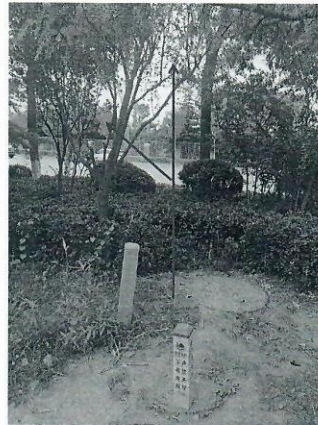
图 2 110kV 空越乙线电缆线路, 向西北衰减。
