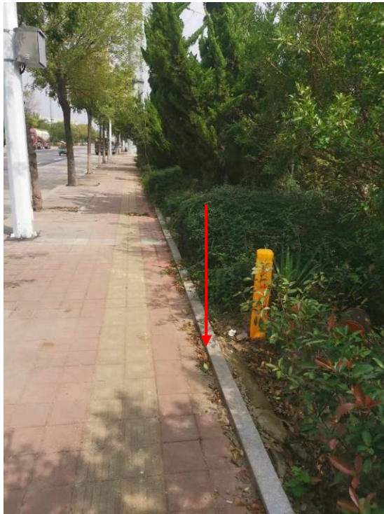
图 7-2 110kV 空港线电缆沟上方检测点
