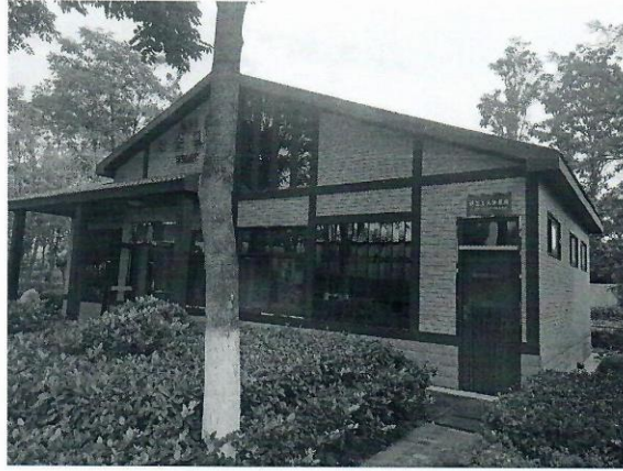
图 1 电缆南侧 2m 处环卫工人休息间
