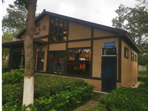
图2-2 电缆南侧2m环卫工人休息间（遵义路南侧）
