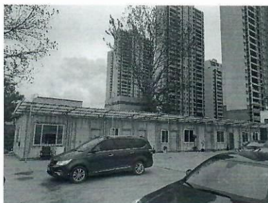
图 7 110kV 黄岛世纪变电站南 6m 飞宇路 989 号办公房 以下空白。
