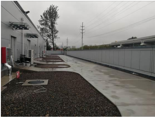
图6-3 变电站内路面硬化
