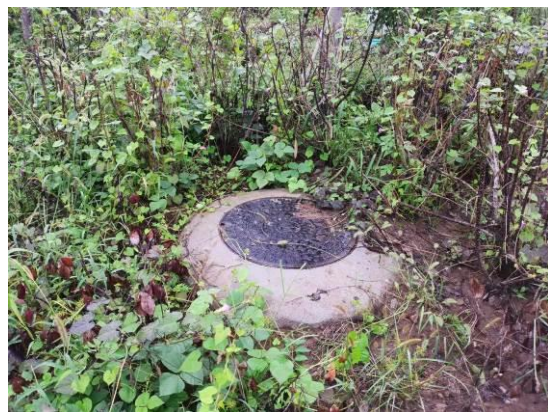
图6-6 电缆沟周围土地恢复
