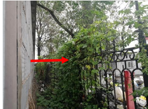
图 4-4 世纪 110kV 变电站南侧
