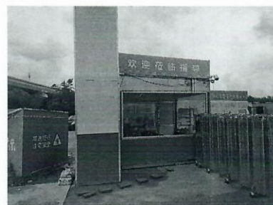
图 6 110kV 黄岛世纪变电站北 21.4m, 工地门卫房
