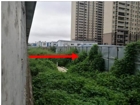
图 4-3 世纪 110kV 变电站东侧
