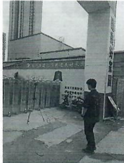
图 1 黄岛世纪 110kV 变电站, 站址北侧
