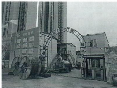
图 5 110kV 黄岛世纪变电站东 16.2m 工地宿舍
