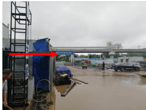
图 4-6 世纪 110kV 变电站北侧
