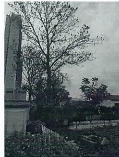
图 2 黄岛世纪 110kV 变电站, 站址南侧
