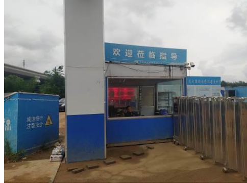
图 2-2 变电站北侧 21.4m 天元集团 门卫房
