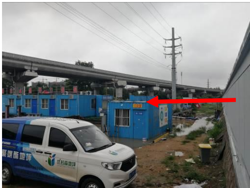
图 4-5 世纪 110kV 变电站西侧
