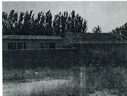
图 2-3 110kV 莲叩京线 139#-140#莲叩京线南 16m 看护房
