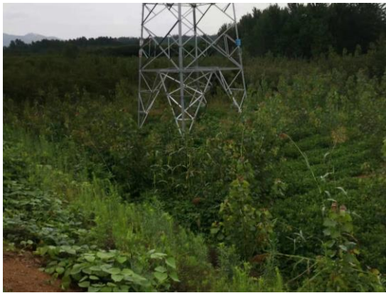
图6-8 (b) 110kV 莲叩京线130#塔基塔基周围土地恢复情况
