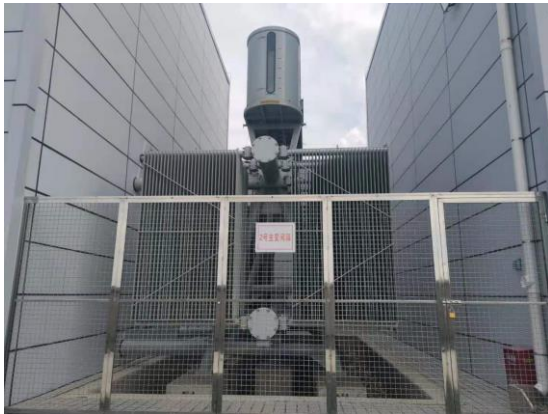
图 4-9 主变散热器
