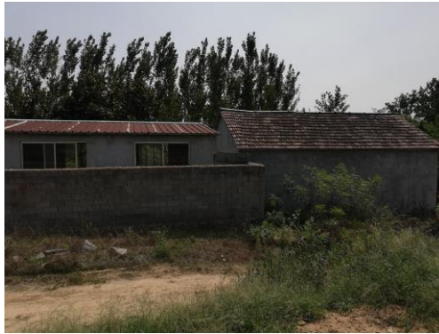
图2-1 110kV莲叩京线139#-140#线南 16m冯家官庄村东北看护房
