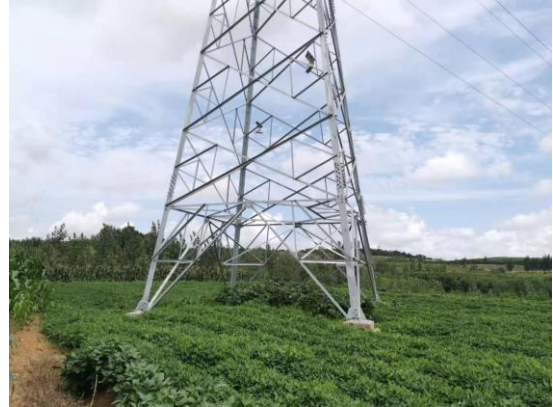
图6-8 (a) 110kV 莲叩京线136#塔基周围土地恢复情况
