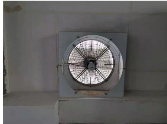
图6-4 配电装置室内通风
