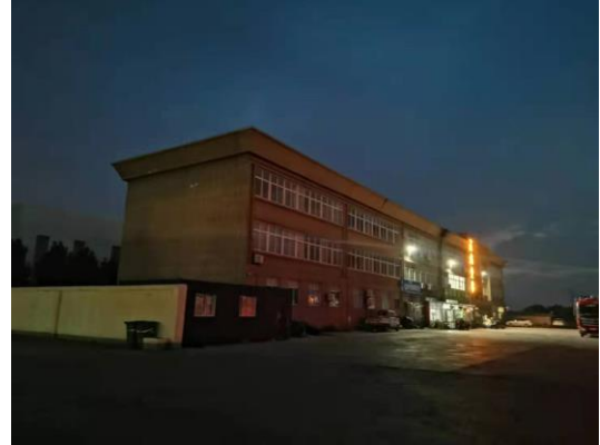
图2-8 110kV州坝董线83#-84#线南22m 沿街楼
