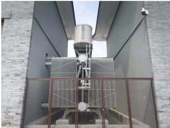
图 4-9 主变散热器
