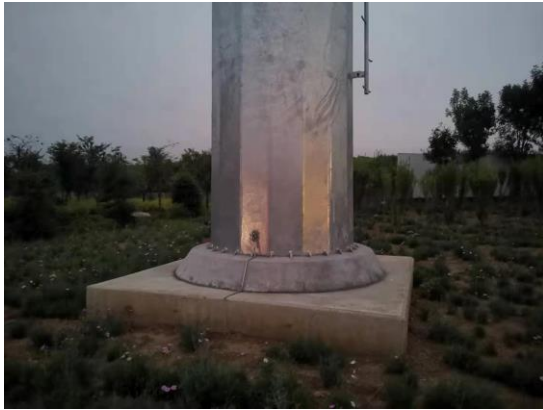
图6-8 (b) 110kV 州坝董线81#塔基周围 土地恢复情况
