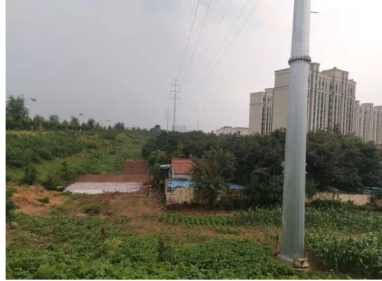
图2-2 110kV州文鼎线30#-29#线下看护房
