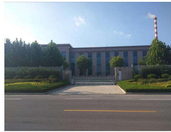
图2-6 110kV州文鼎线74#-75#线东25m 莒县经济开发区综治工作中心
