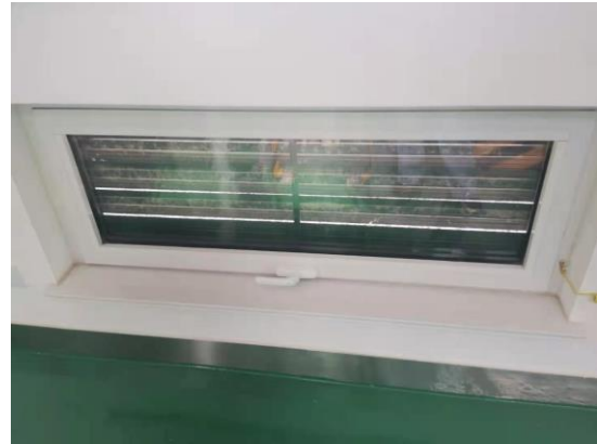
图6-4 配电装置室内通风
