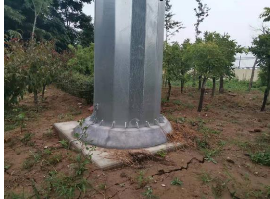
图6-8 (a) 110kV 州文鼎线65#塔基周围 土地恢复情况
