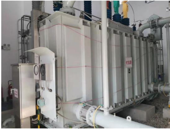
图 4-7 #1 主变压器
