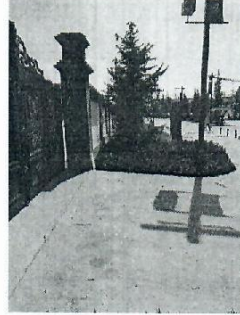
图 1-4 日照文心 110kV 变电站址西侧
