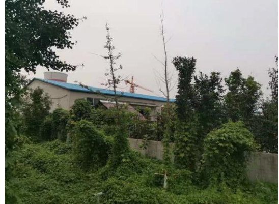
图2-4 110kV州文鼎线72#-73#线东10m 莒县长城建筑有限公司
