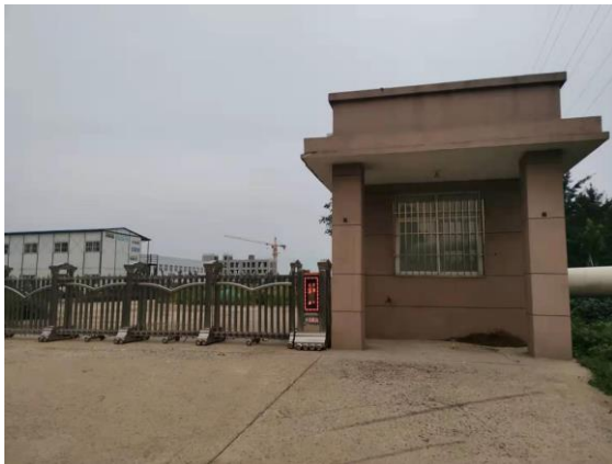
图2-5 110kV州文鼎线74#-75#线东8m门 卫室
