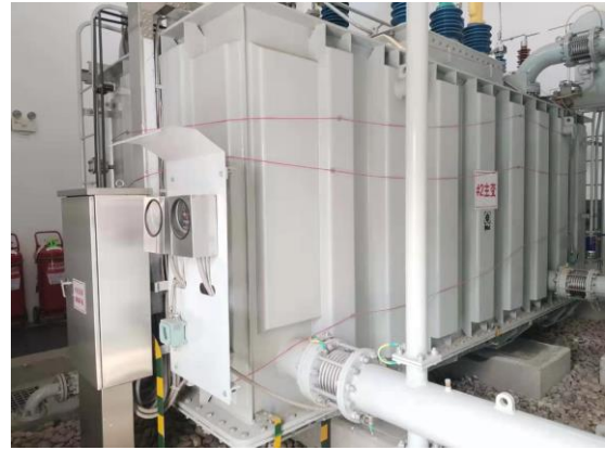
图 4-8 #2 主变压器
