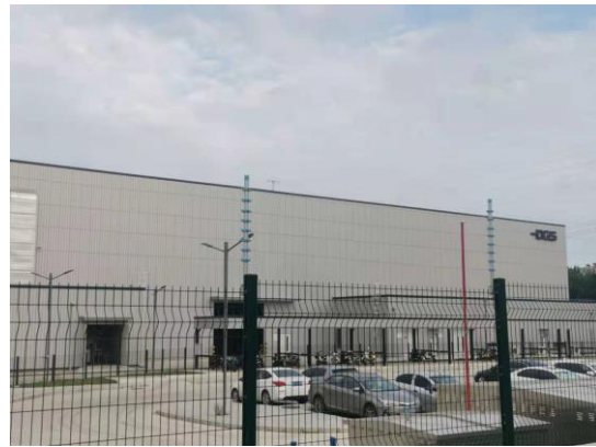
图2-10 110kV傅古裴线13#-15#线北24m德志汽车零部件有限公司厂房
