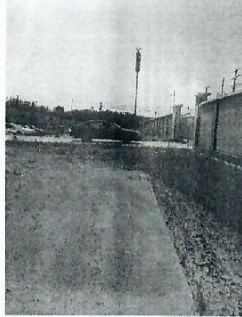
图 1-1 山东日照东港裴家（臧家荒）110kV 变电站站址东侧距围墙 5m 处
