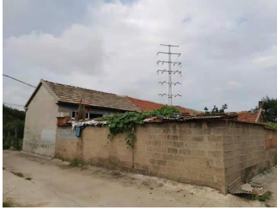
图2-7 110kV东裴牵线7#-8#线南15m金家沟村民房
