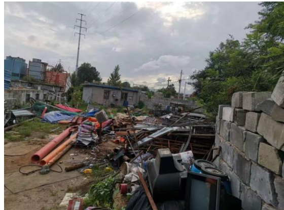
图2-6 110kV东裴牵线6#-7#线下废品收购站
