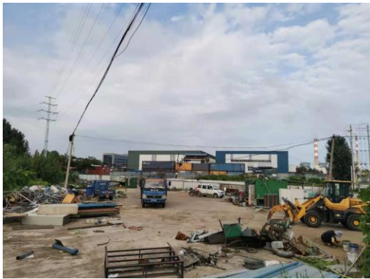
图2-9 110kV东裴牵线9#-10#线下跨越物流园
