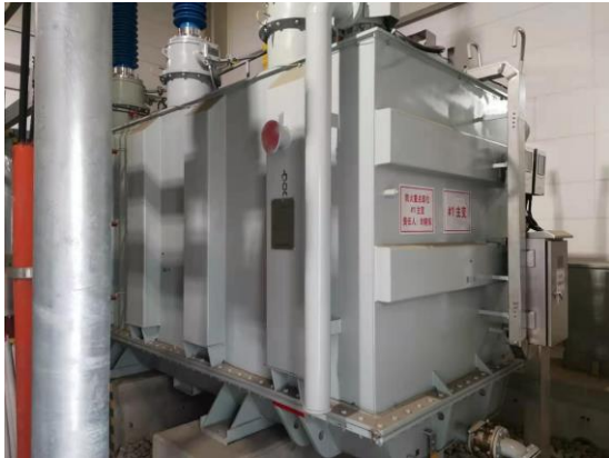
图 4-7 #1 主变压器
