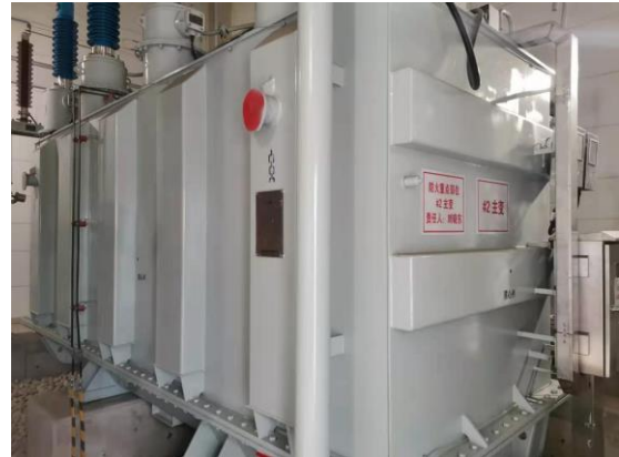
图 4-8 #2 主变压器
