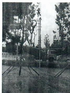
图 2-2 110kV 傅古裴线 15#-16#杆塔, 向北 侧衰减
