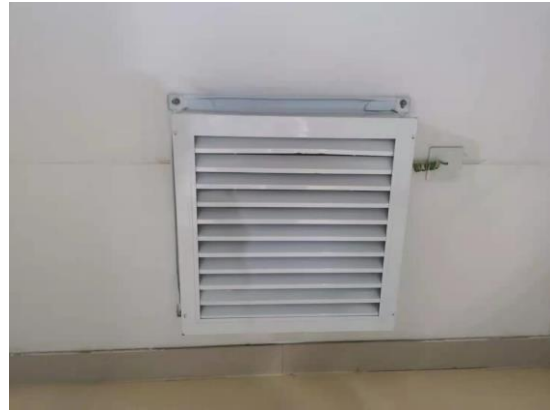
图6-4 配电装置室内通风
