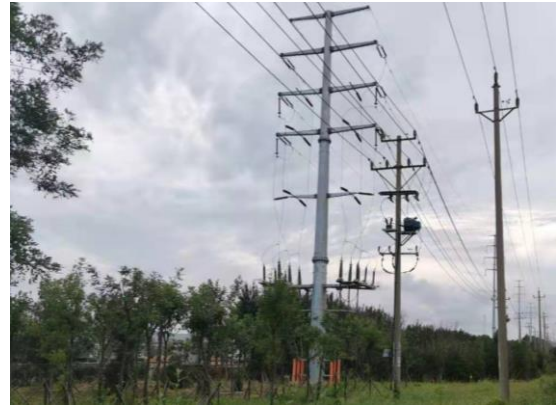
图6-8 (a) 塔基周围土地恢复情况
