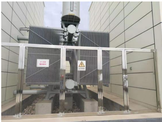
图 4-9 主变散热器
