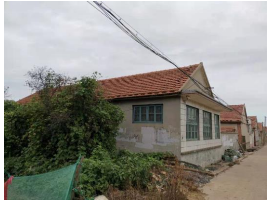
图2-2 110kV东裴牵线5#-6#线南20m张家村民房
