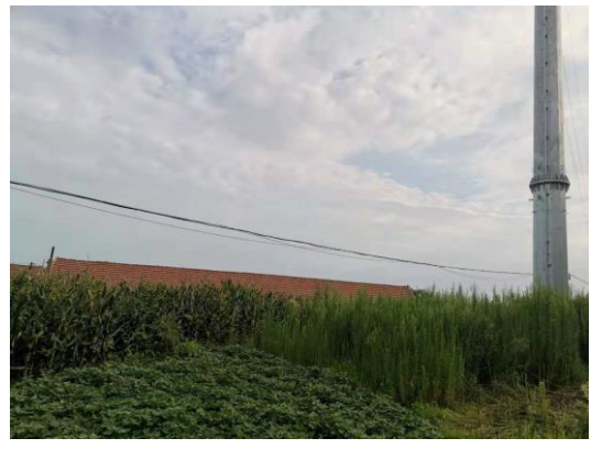
图2-8 110kV东裴牵线8#-9#线南15m金家沟村民房
