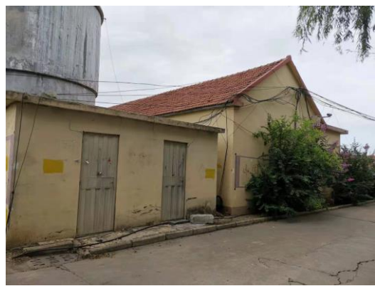
图2-4 110kV东裴牵线5#-6#线南25m路家沟村民房
