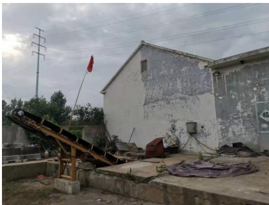
图2-5 110kV东裴牵线6#-7#线南8m金家沟村民房
