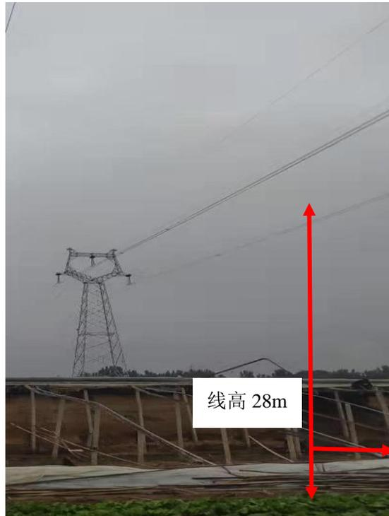
图 7-2 220kV 章宅线 046#-045#衰减断面
