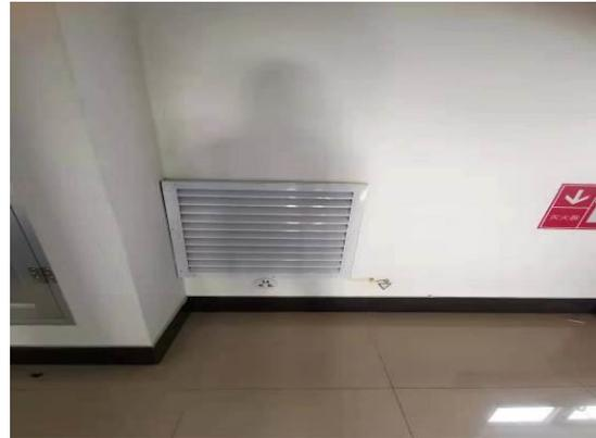
图6-4 220kV 配电装置室通风
