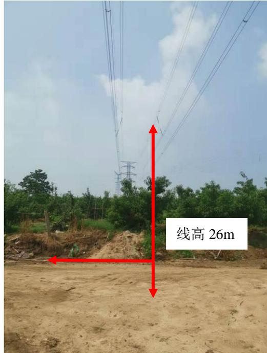
图 7-1 220kV 石宅 I 线/220kV 石宅 II 线同塔双回衰减断面
