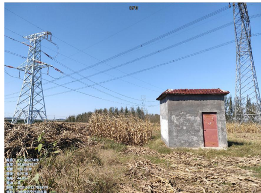
图2-1 110kV圣东II线38#~39#之间，线北25m，黄家岭村北侧机井房
