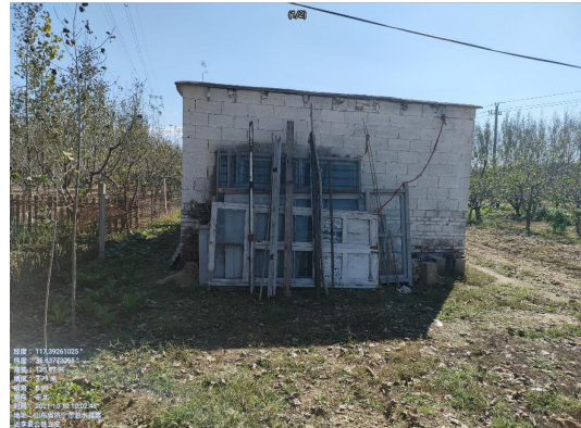
图2-1 110kV圣东II线26#~27#之间，线南1m果园看护房
