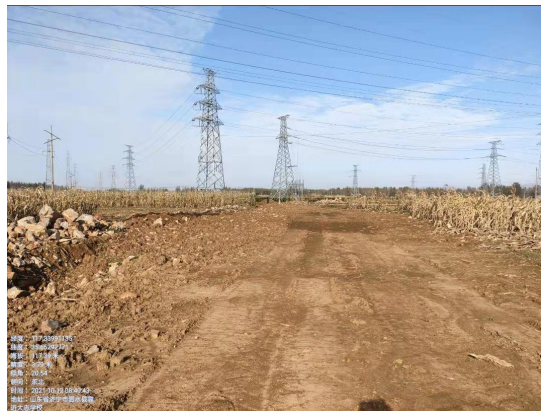
图 6-2 电缆沟上方土地恢复
